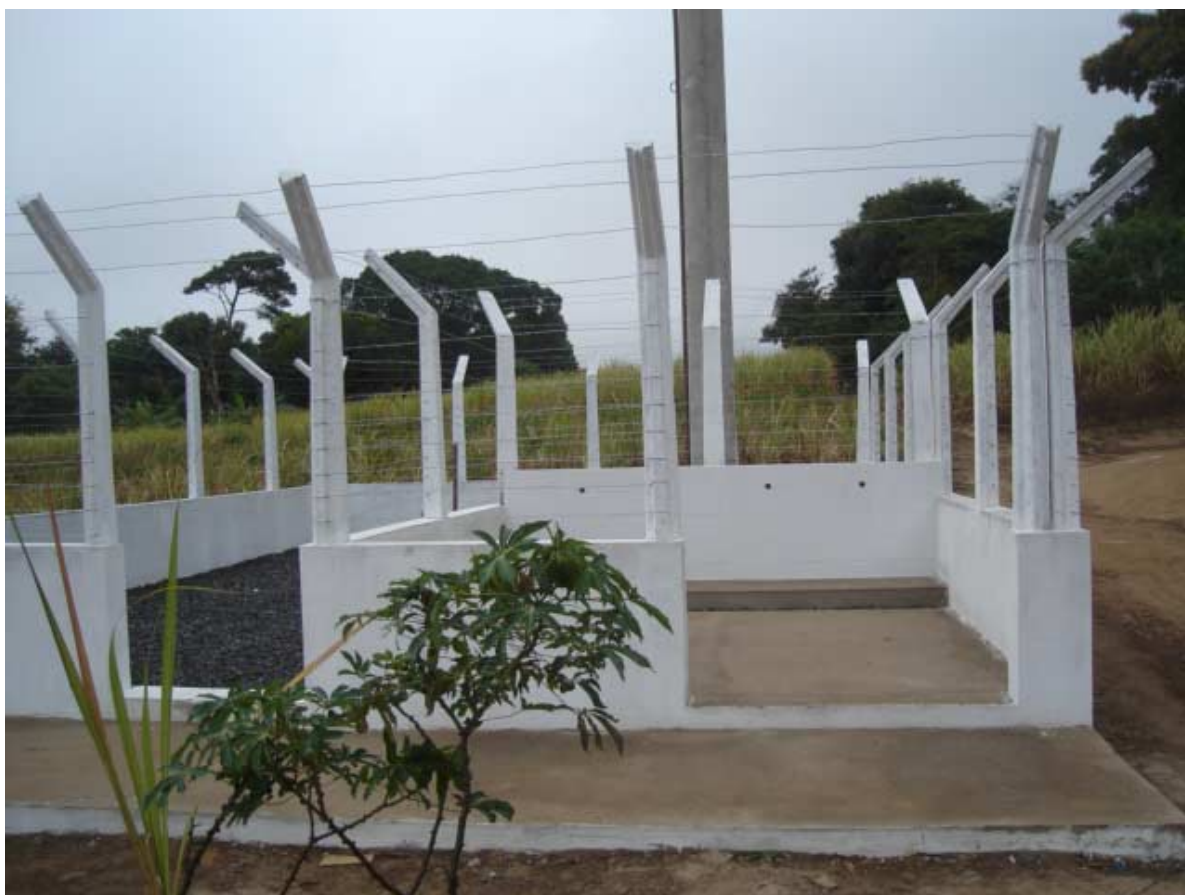
Foto 7.1 - Fase construtiva do SSA Sítio Jussara
