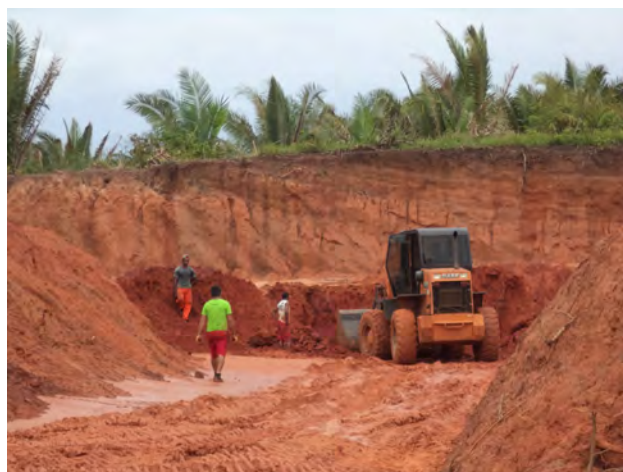
Foto 4.4 – Extração de material de empréstimo no Afloramento LL 015.
