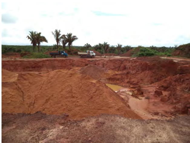
Foto 4.6 - Extração de saibro no Afloramento LL 015.
