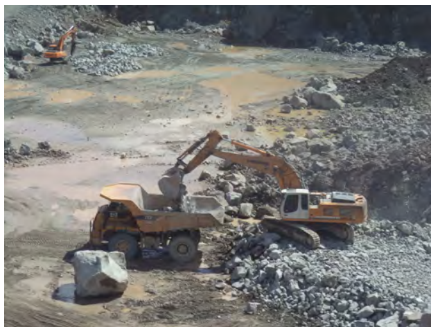
Foto 6.3 – Retroescavadeira abastecendo caminhão basculante fora de estrada (Afloramento LL 021).
