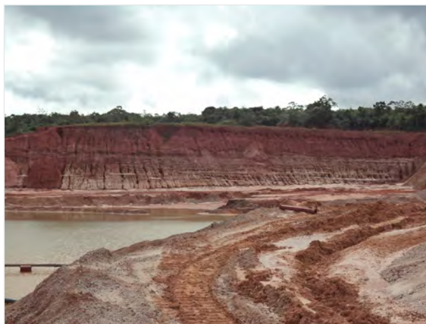
Foto 7.3 – Remoção de solo e cobertura vegetal em área de extração de areia nos sedimentos do Grupo Barreiras em São Luís (Afloramento KA 003).
