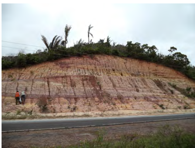
Foto 3.7 – Afloramento LL 012 – Alternância de camadas de siltitos laminados, arroxeados/arenitos creme-alaranjados rosados.
