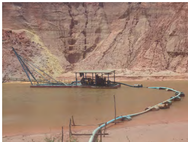
Foto. 7.6 – Mineração de areia com o emprego de draga sem dispositivo de contenção de vazamentos de óleos e graxas, expondo o freático a contaminantes. Município de São Luís (Afloramento KA 008).
