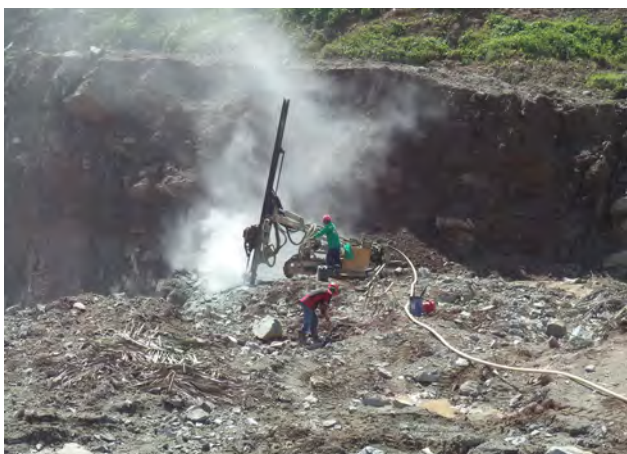
Foto 6.2 – Atuação do rompedor hidráulico quebrando blocos de rocha (Afloramento LL 021).
