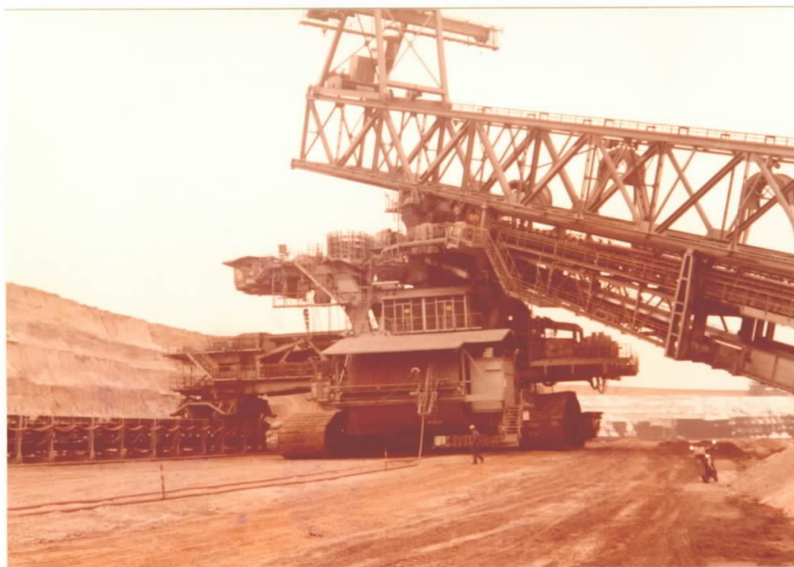
Fotos 3 e 4 - Mina Fortuna - escavadeira de rodas para remoção de 200.000 m 3 /dia.
