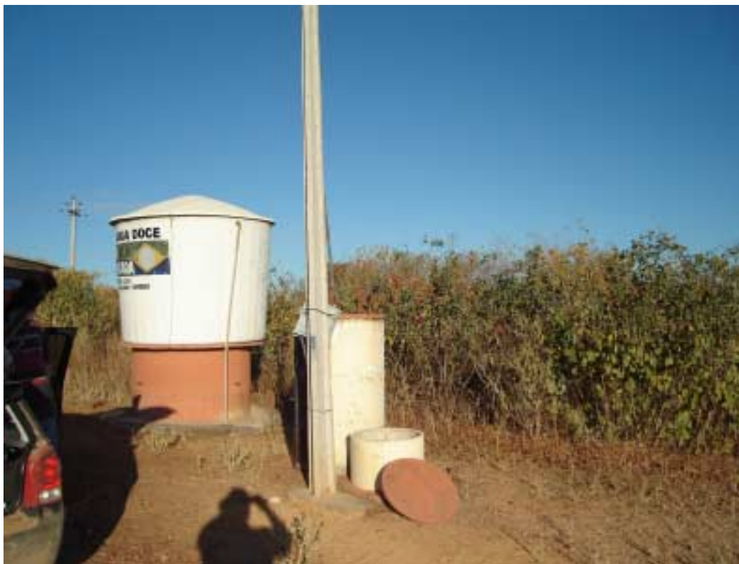
Foto 2.1 - Situação pretérita do poço do Assentamento Altamira
