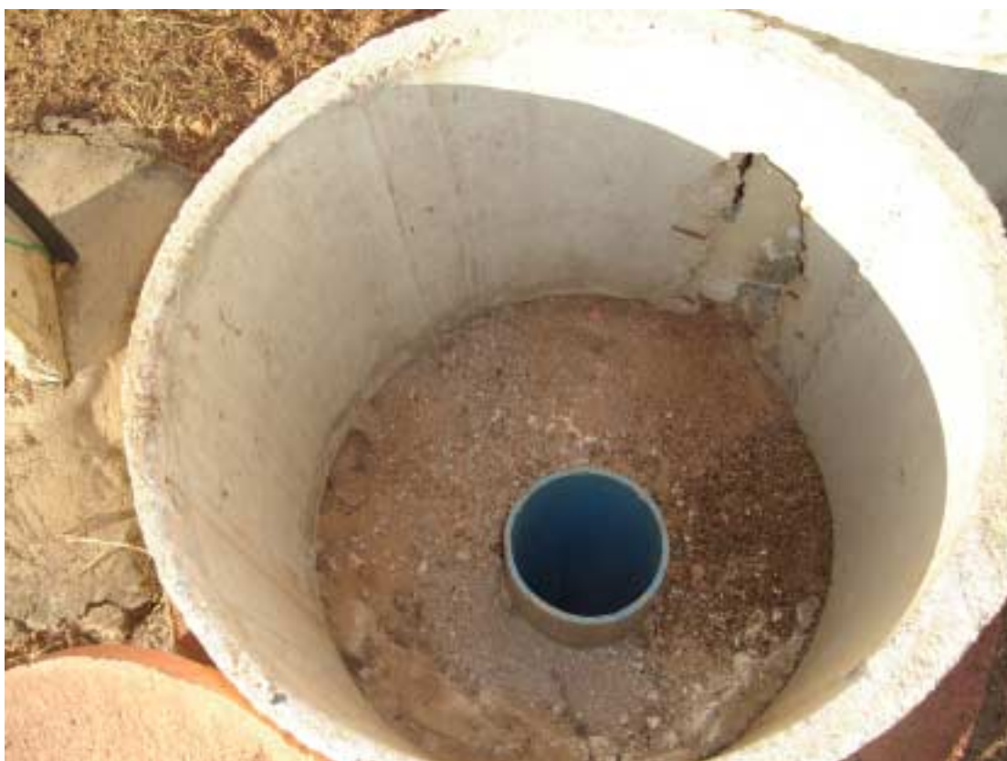
Foto 2. - Situação pretérita do poço do Assentamento Altamira
