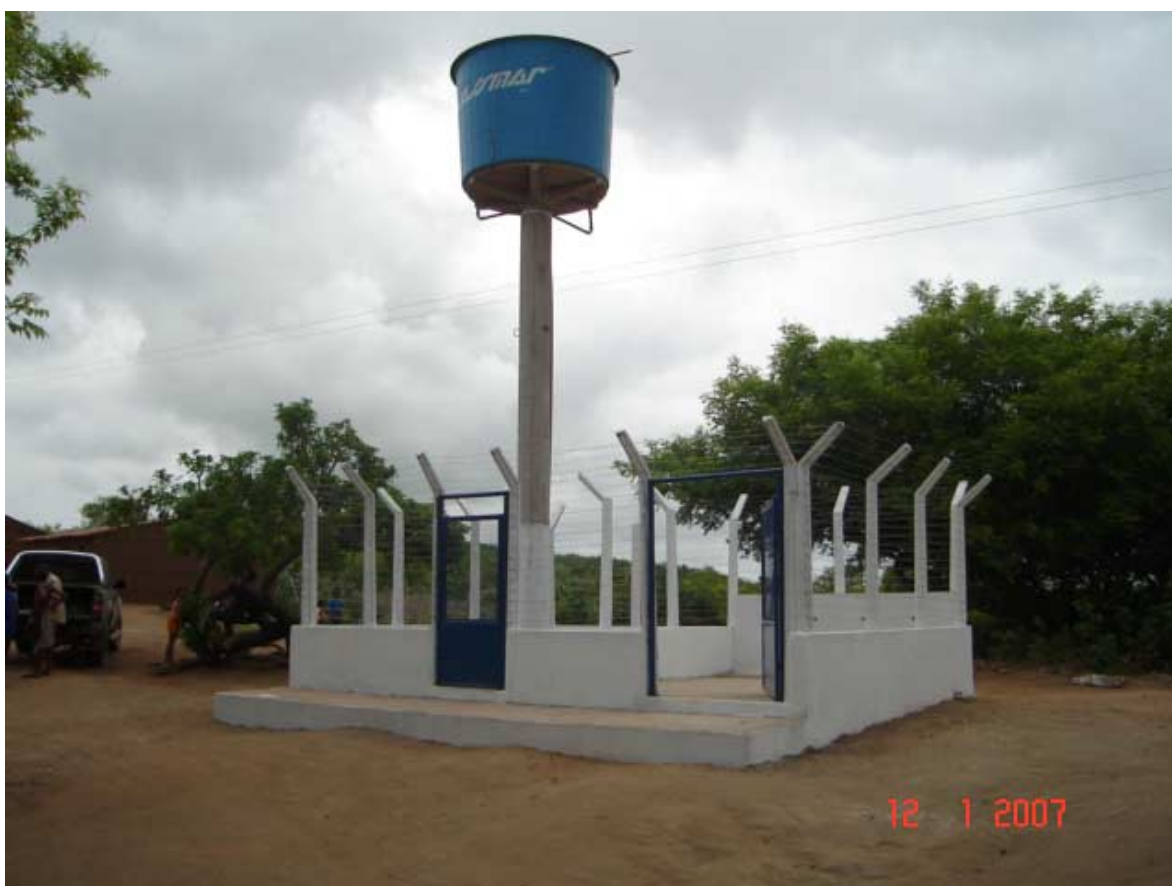
Foto 8.1 - Aspecto do SSA Sítio Tamboril concluído
