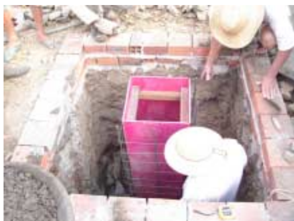
Fotos 7.2 e 7.3 - Caixa d'água elevada e sua fundação, em fase construtiva, de concreto armado
