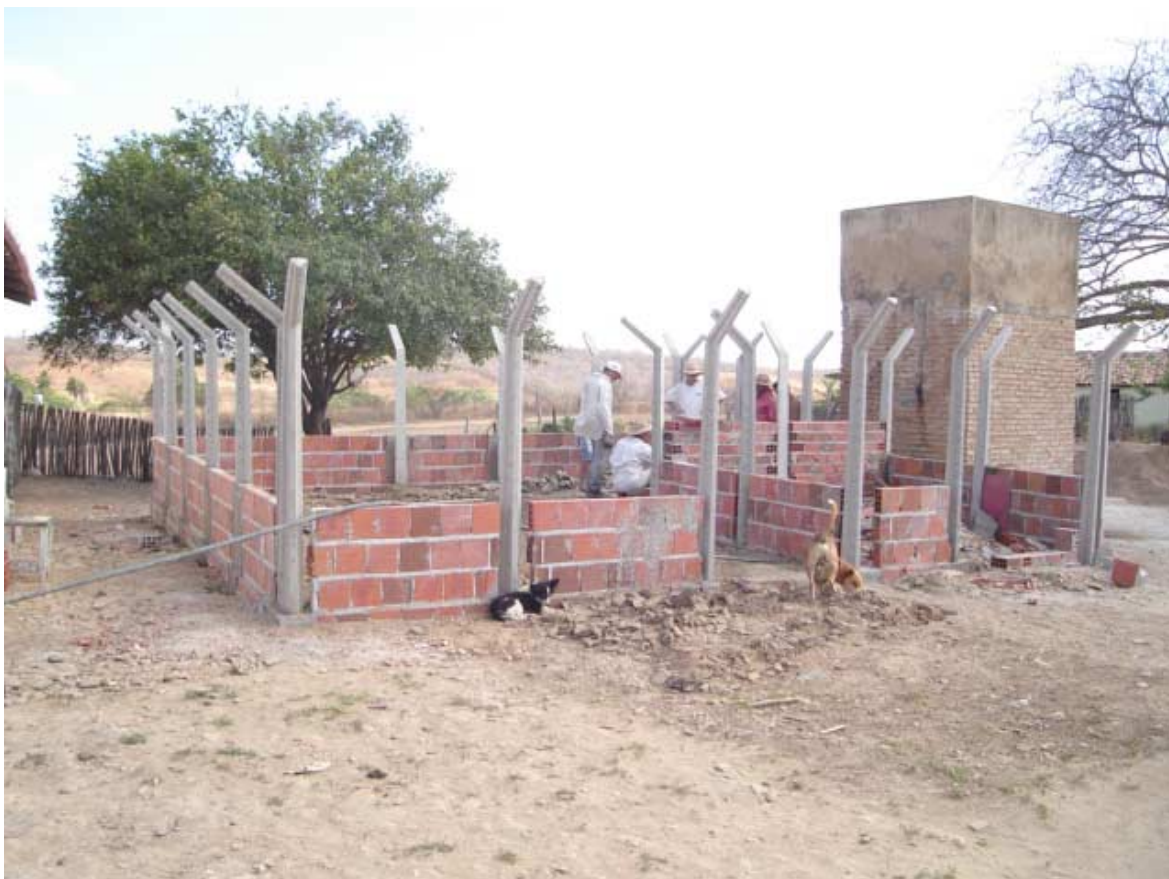
Foto 7.1 - Mureta em fase de construção
