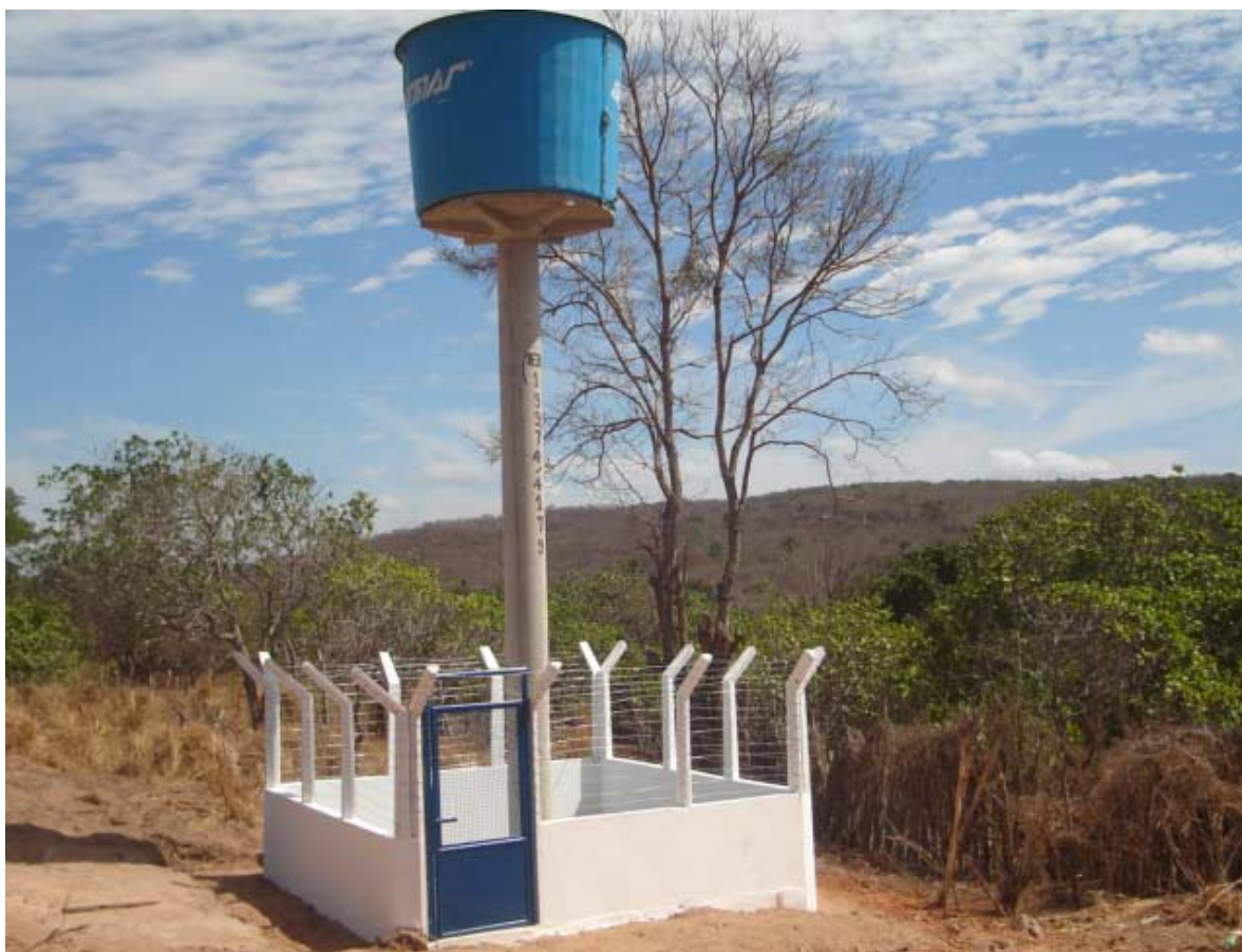
Foto 8.1 - Aspecto do SSA Povoado Grossos concluído
