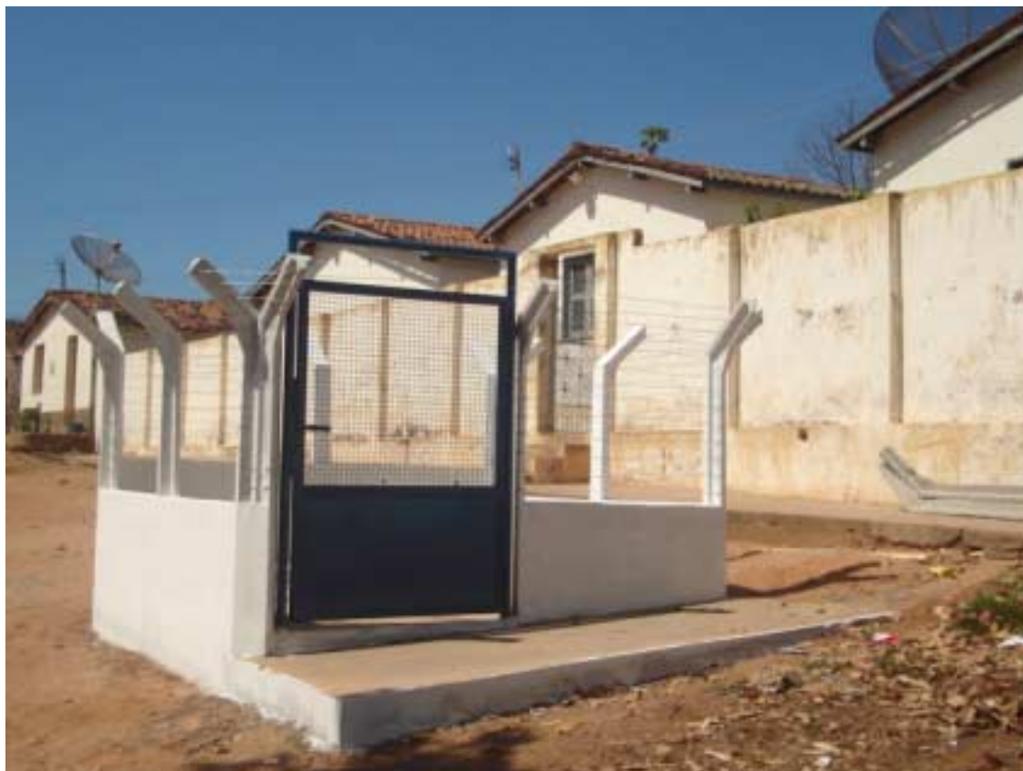
Foto 7.1 - Cercado de proteção das instalações do poço, no Povoado de Grossos
