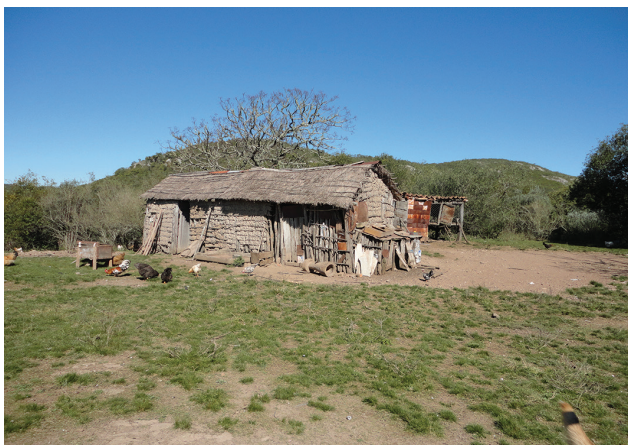
Figura 180: Casa de pau-a-pique, taipa de mão ou barro: ponto inicial da trilha até a entrada da caverna.
