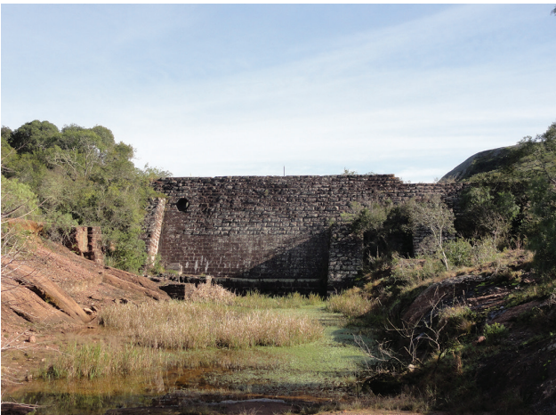
Figura 24: Barragem construída pelos belgas em 1899. Fotografia: Carlos Peixoto, 2013.
