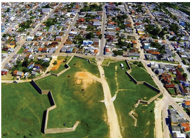
Figura 9: Vista aérea do Forte Dom Pedro II, com sua forma de estrela hexagonal. Fonte: http://galeradopedal.net/
