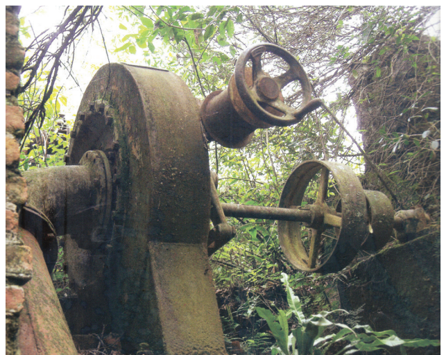
Figura 30: Estruturas remanescentes do Engenho da Mineradora Companhia Lopes e Tallourd e da Companhia Belga (1898-1909). Fotografia: Nina Boeira, 2013
