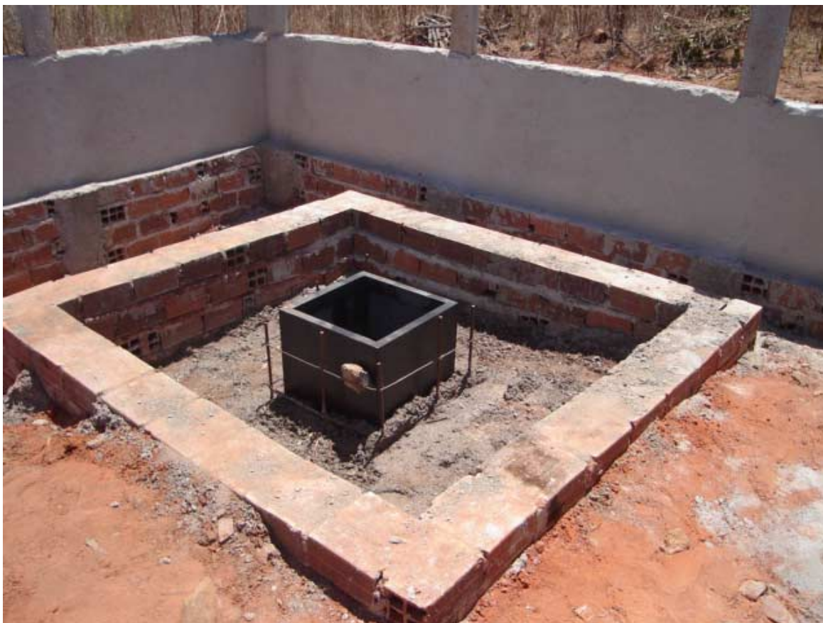
Foto 7.1- Base da estrutura para caixa d'água elevada
