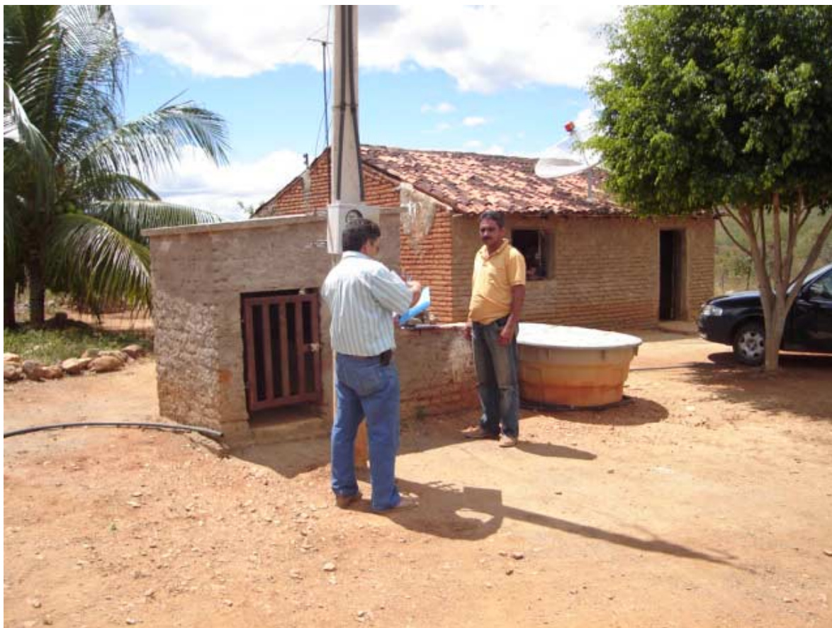
Foto 5.1 - Diagnóstico técnico do poço
