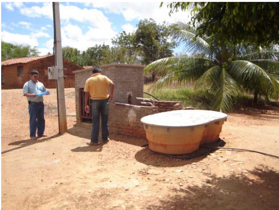
Foto 2.1 - Situação pretérita do poço do Sítio Saco
