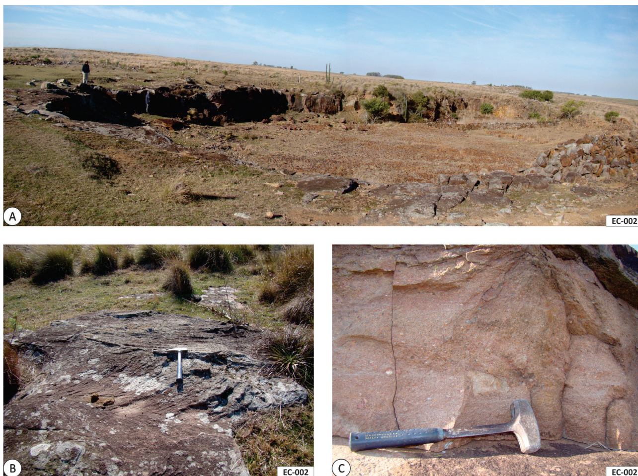
Figura 31 - (A) Pedreira da Viação Férrea com arenitos silicificados, piritosos e ferruginosos, com (B) estratificação cruzada de grande porte e (C) arenito sub-arcoseano conglomerático. Fm. Rio Bonito.
