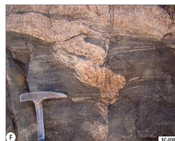
Figura 51 - (A a F) Vertedouro da Barragem da Sanga Rasa. Afloramentos de gnaisses tonalíticos/dioríticos e metatonalitos com injeções de leucogranitos rosados, alguns deformados junto com os metatonalitos.
