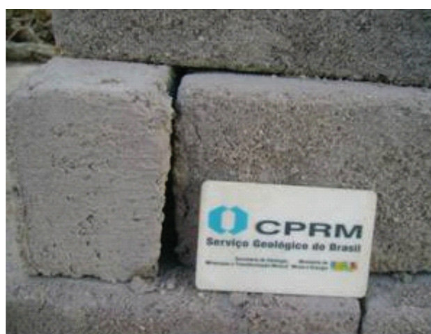
Foto 5.2 - Tijolo artesanal cuja matéria-prima são sedimentos areno-argilosos, também denominado argila “magra”.
