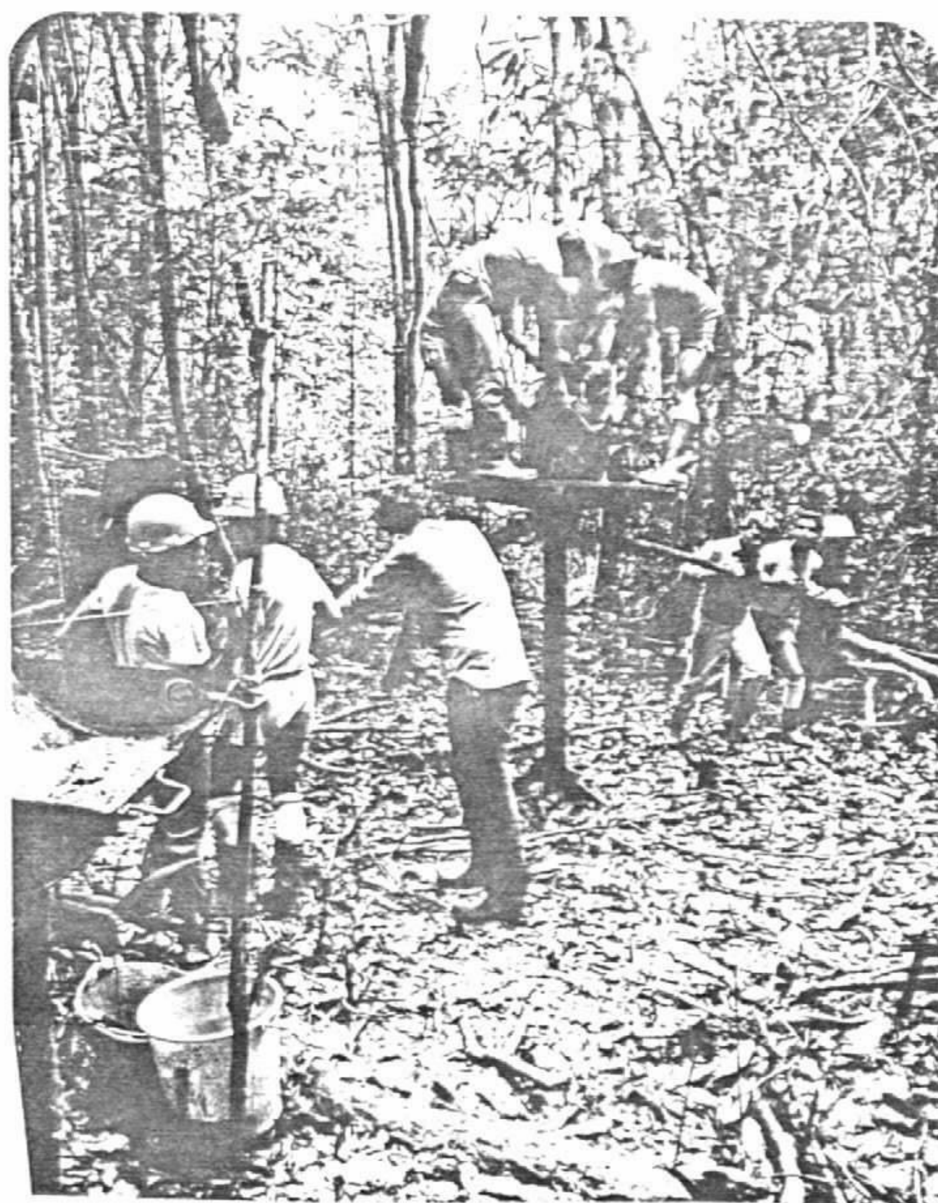
FOTO 46 : A sondagem Banka foi a principal atividade de pesquisa nas áreas. Foram realizados 1.134,28 metros de sondagem, utilizando-se 3 sondas SOCAR de 4 polegadas, da CPRM.
