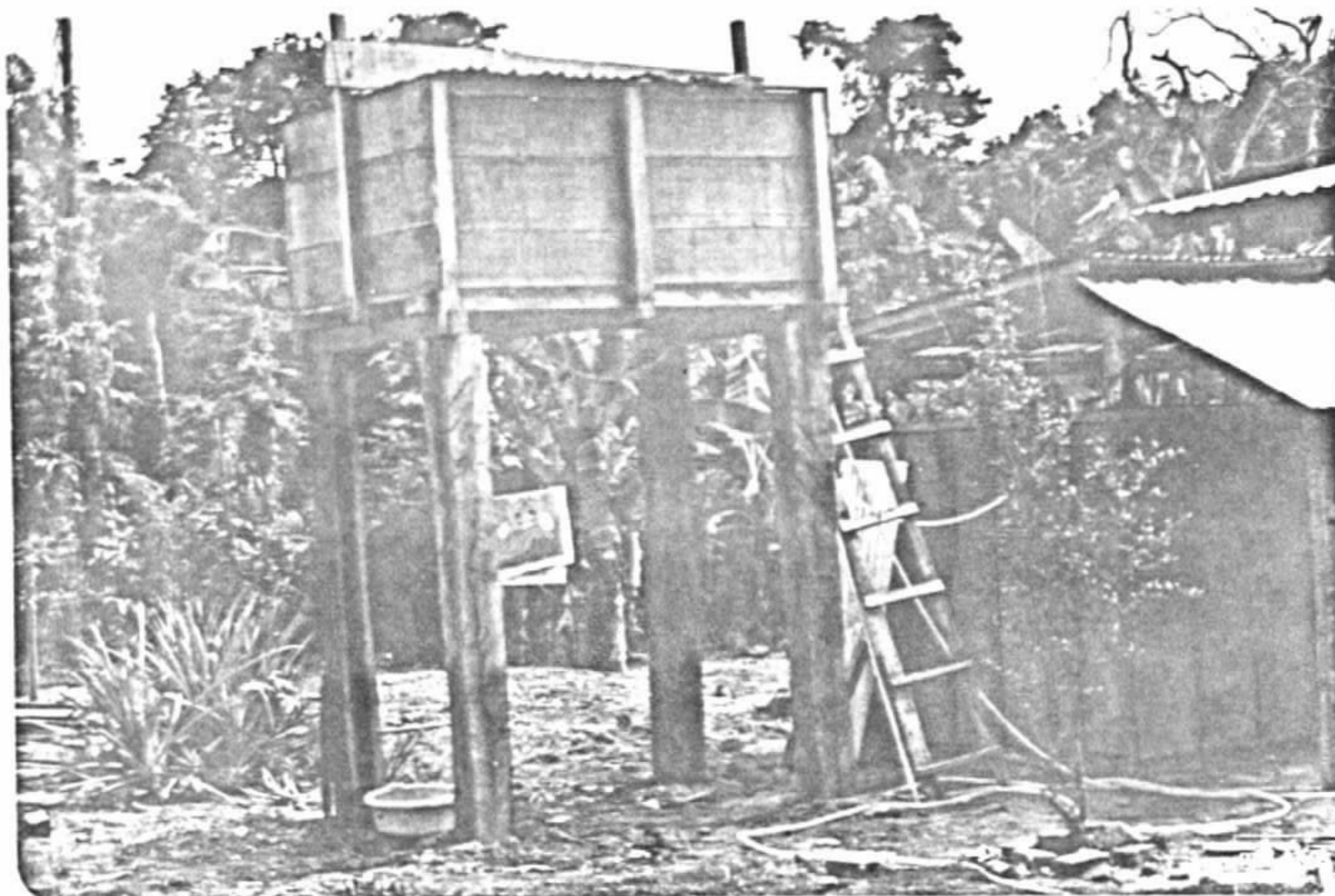
FOTO 35 :: Caixa d'água construída para abastecimen- to do refeitório e dos sanitários.
