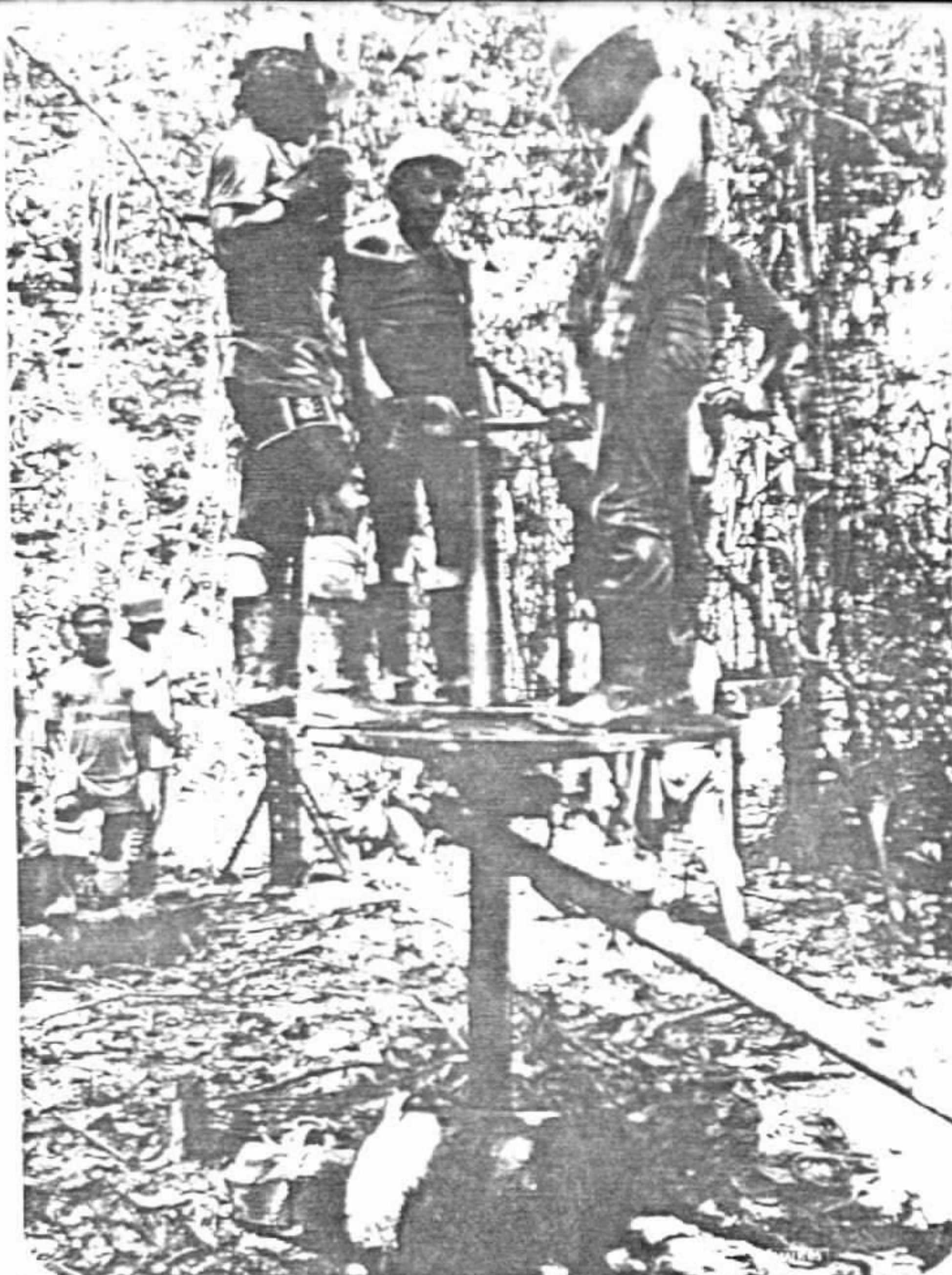
FOTO 53 : A operação de retirada do amostrador da Sonda Banka
