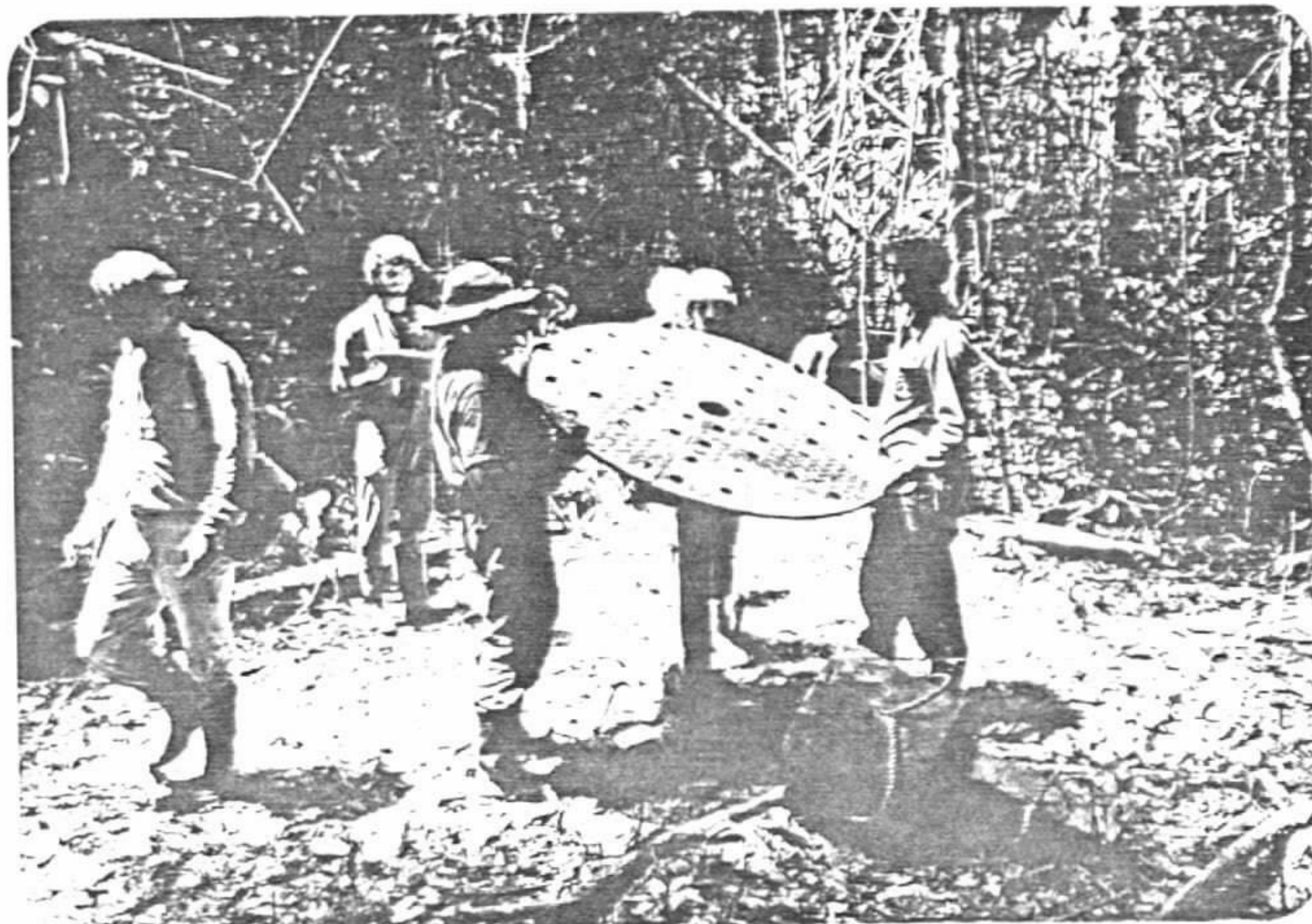
FOTO 49 : Operação de desmontagem da plataforma da Sonda Banka para transporte.
