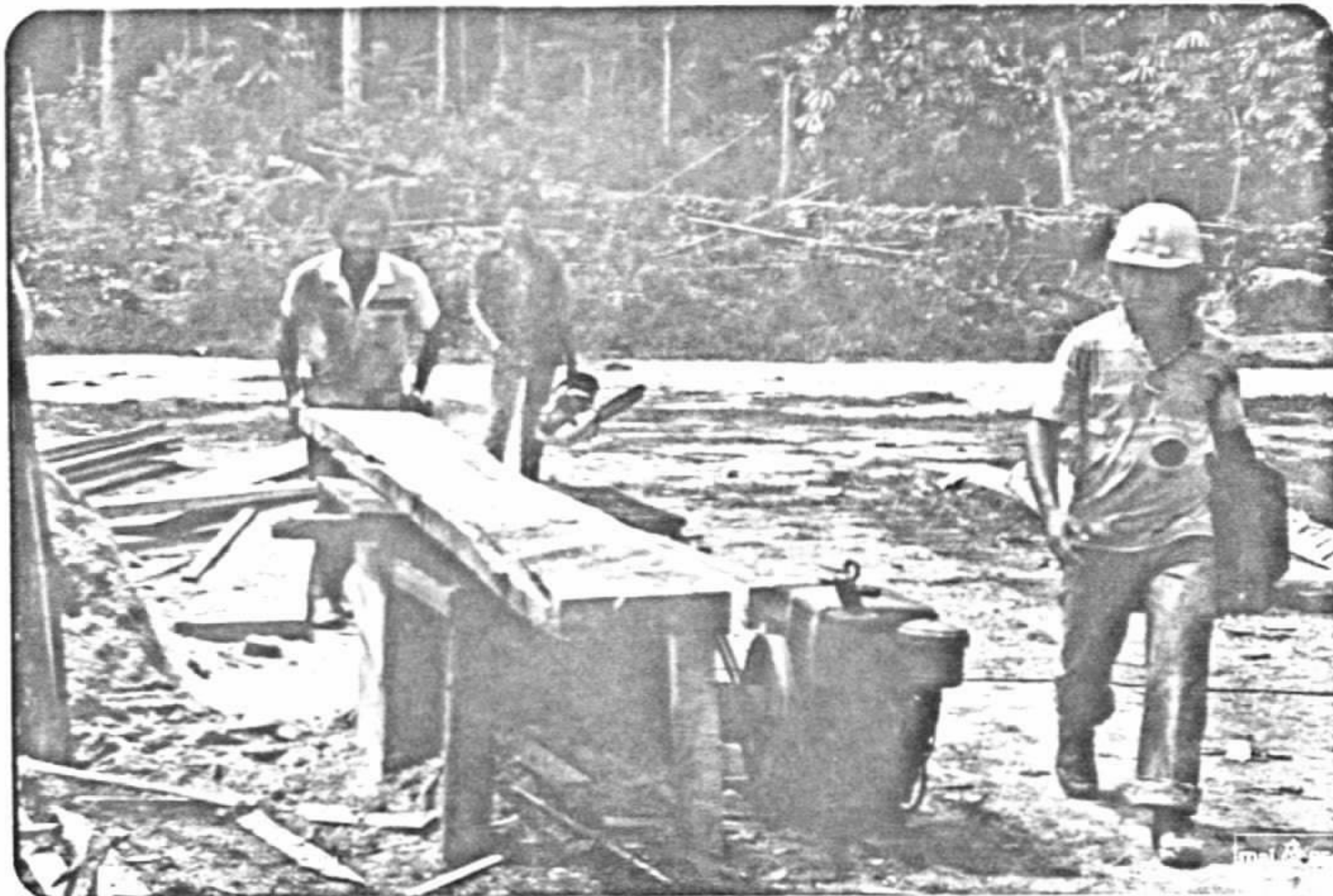
FOTO 28 : Madeira sendo aparelhada para uso nas construções.
