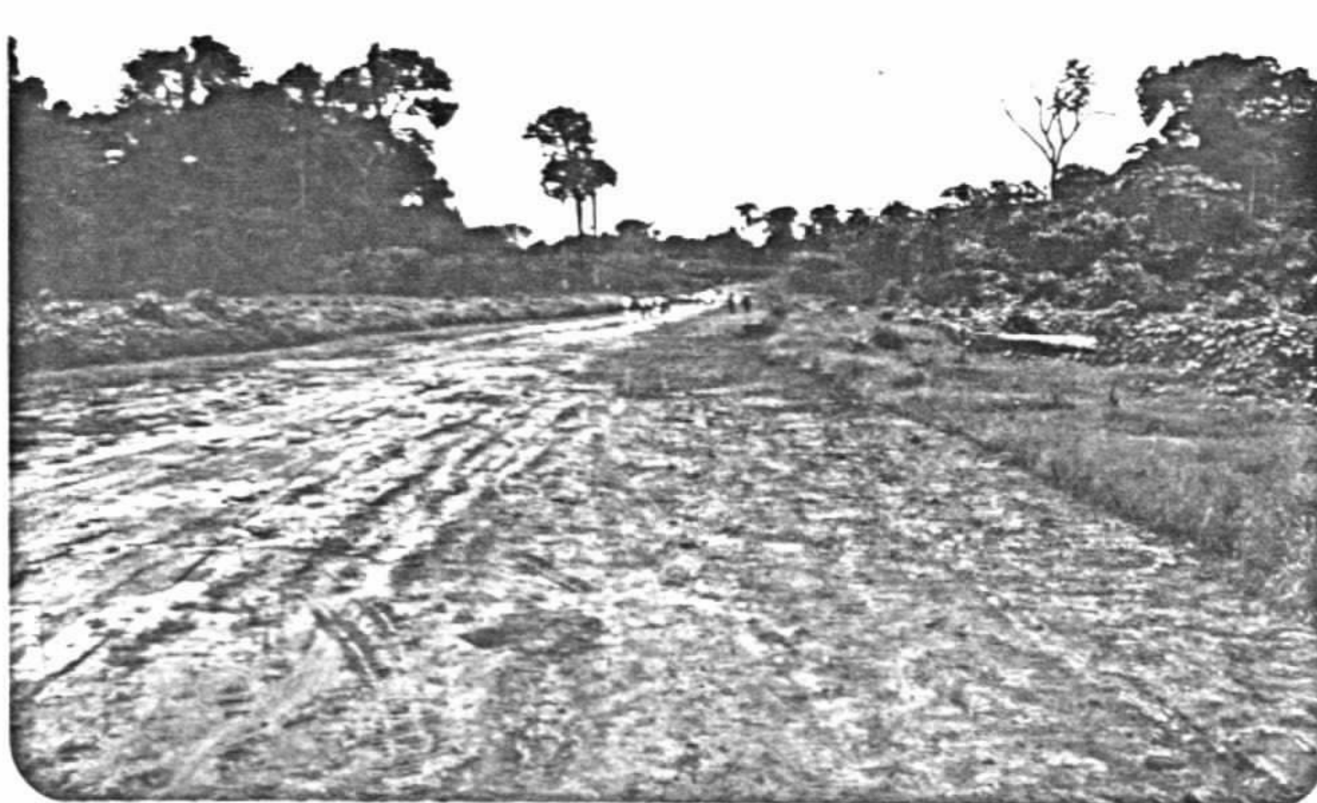
FOTO 38 : Aspecto atual da pista de pouso Comandante Jari , ampliada para 600 metros de extensão, o que permite melhores condições de pouso e decolagem.
