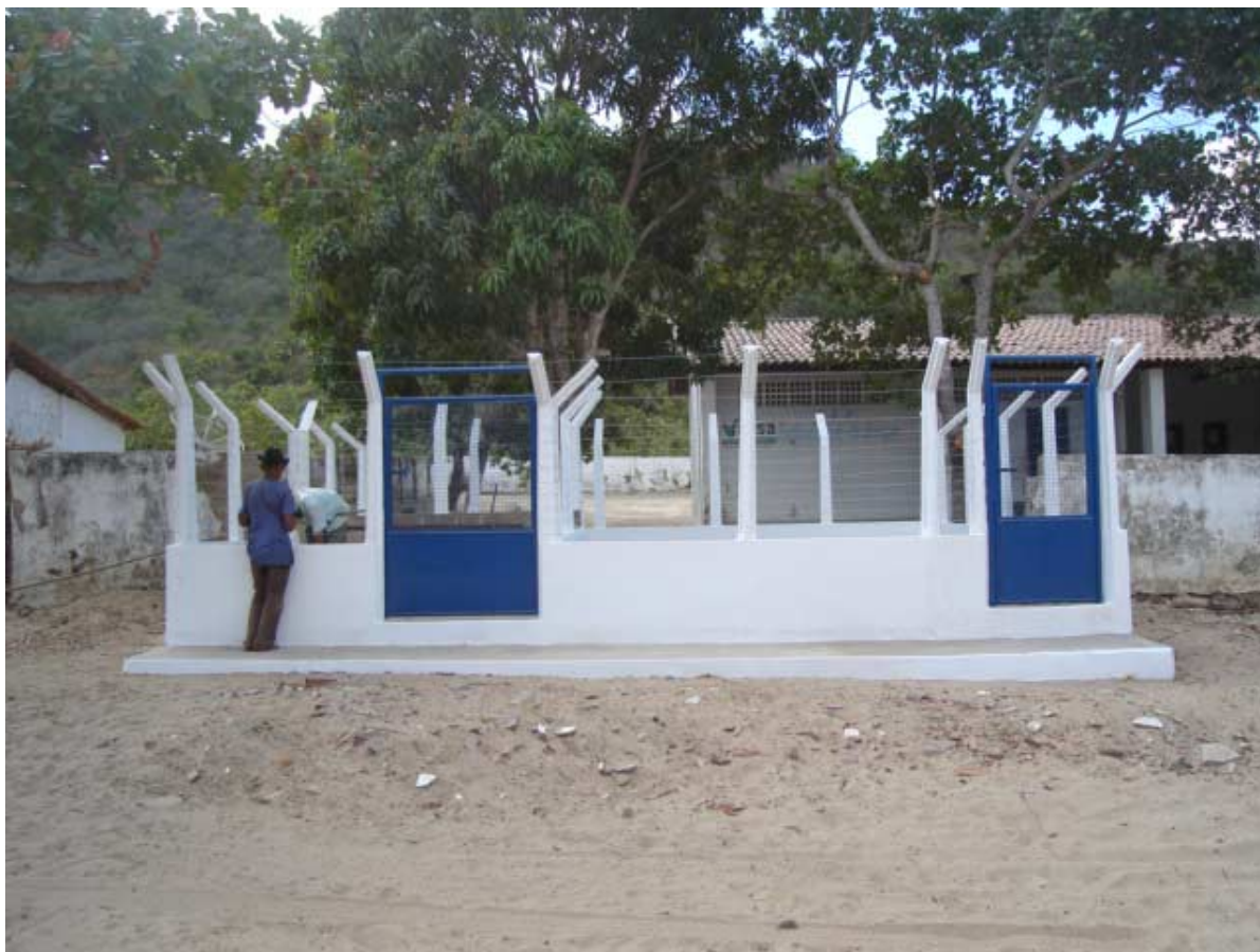
Foto 7.2 - SSA Sítio Sumaré em fase conclusiva
