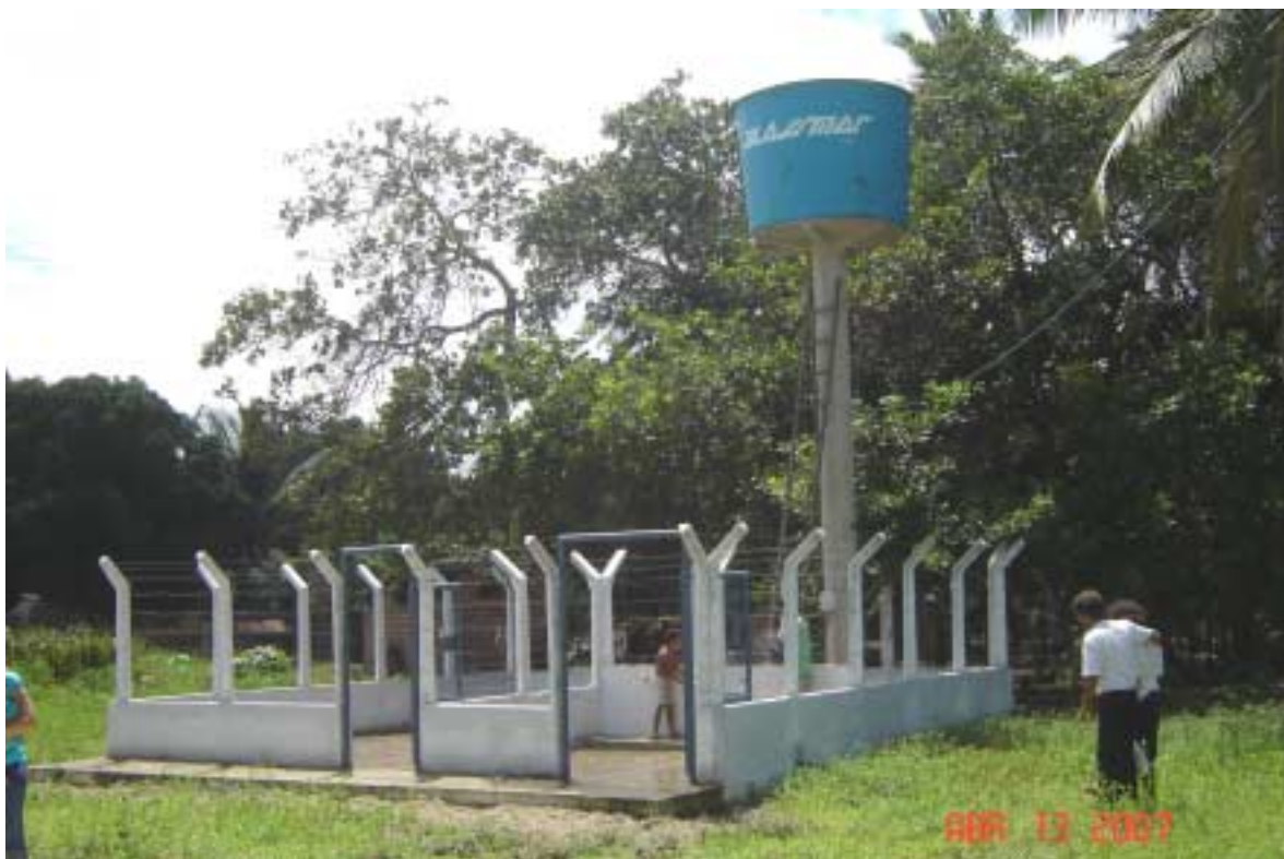
Foto 7.2 - Aspecto do SSA Sítio Alagadiço Seco concluído
