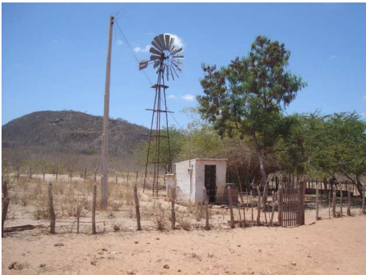
Foto 5.1 - Diagnóstico técnico do poço Sítio Novo
