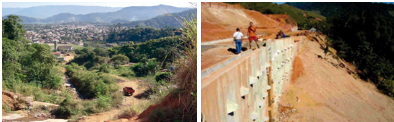
Figura 1 – (a) Vista da região de Angra dos Reis, RJ, área de estudo do Projeto Geological Hazards in Angra dos Reis Area, Rio de Janeiro, Brazil; (b) Área de contenção de barreiras, na mesma região, ao longo da BR-101.
