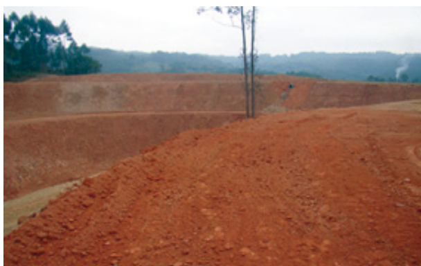
Figura 4 - Cobertura de argila sobre os rejeitos sulfetados.
