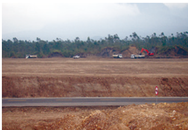
Figura 2 - Conformação das pilhas de rejeito e reconstrução topográfica.
