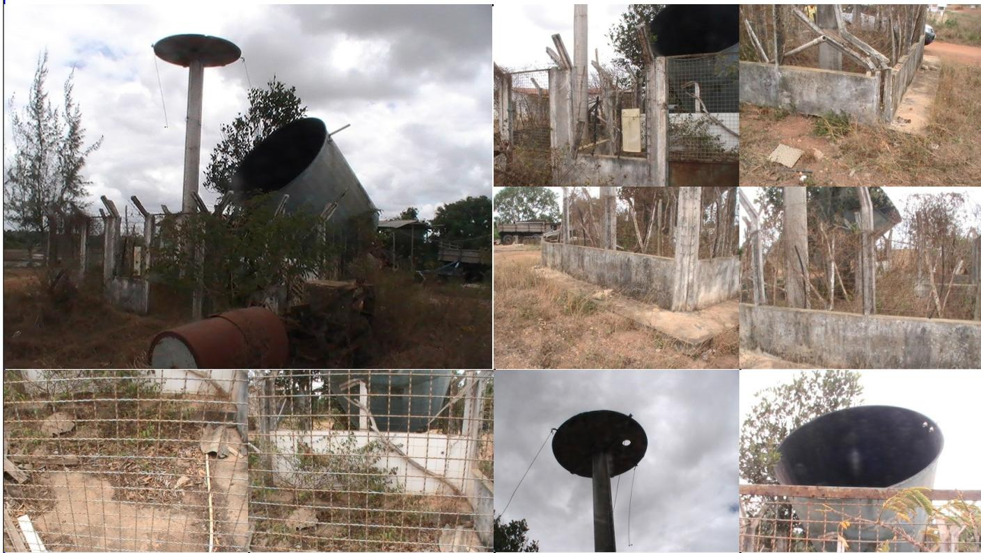
O sistema está abandonado e a caixa foi removida. O sistema nunca funcionou porque a bomba foi instalada mas a energia elétrica não foi colocada.
