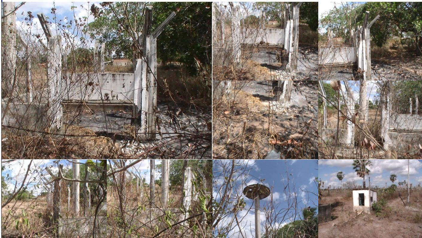
SSAS em estado de completo abandono, nunca operou devido a problemas com a comunidade, energia elétrica e roubo de equipamentos. Problema CONSAD, assumido pela EMATER - RN. SSAS de 2006.
