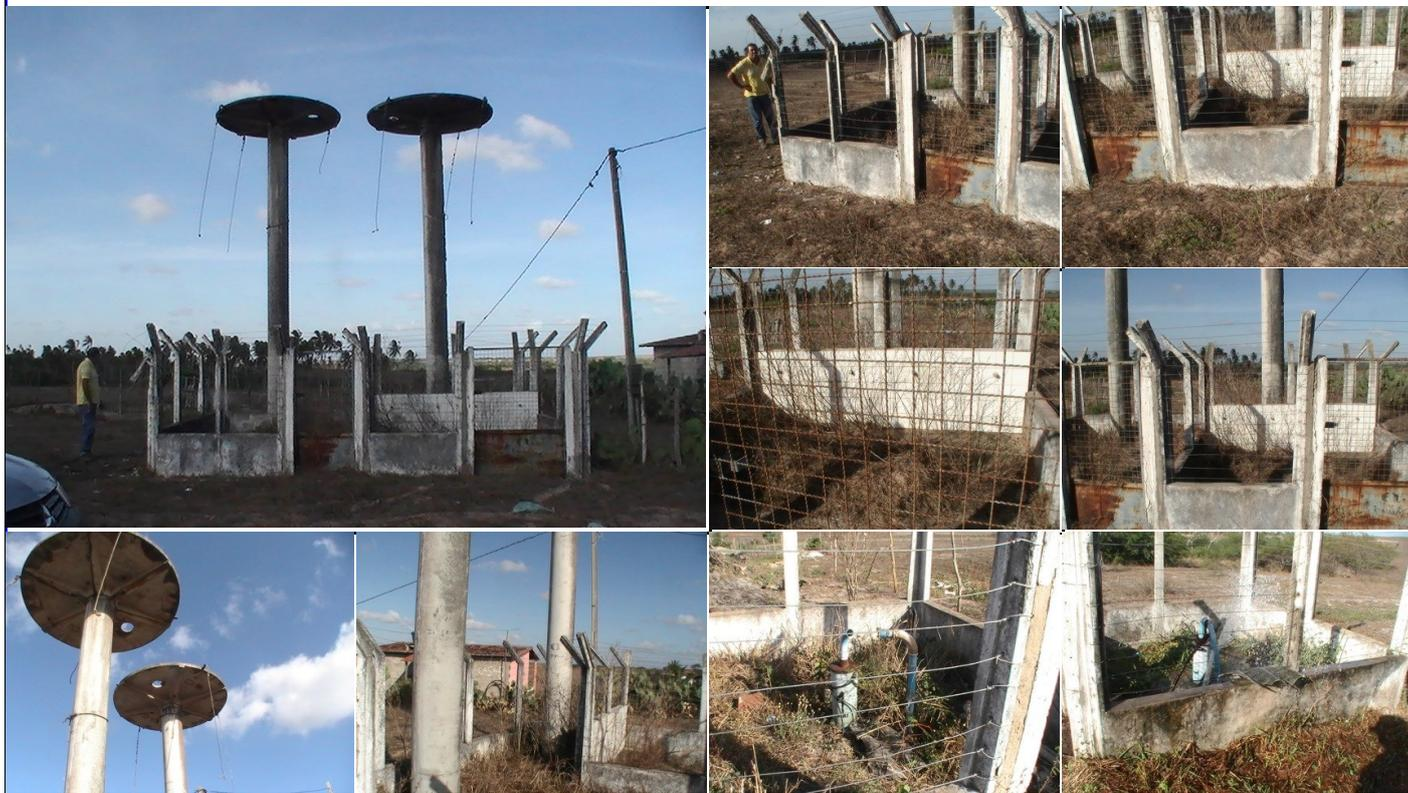
O sistema está abandonado e as caixas foras removidas ou destruídas. Existem dois poços que abasteciam o chafariz mas um está paralisado e o outro é usado para abastecimento de caminhão pipa.
