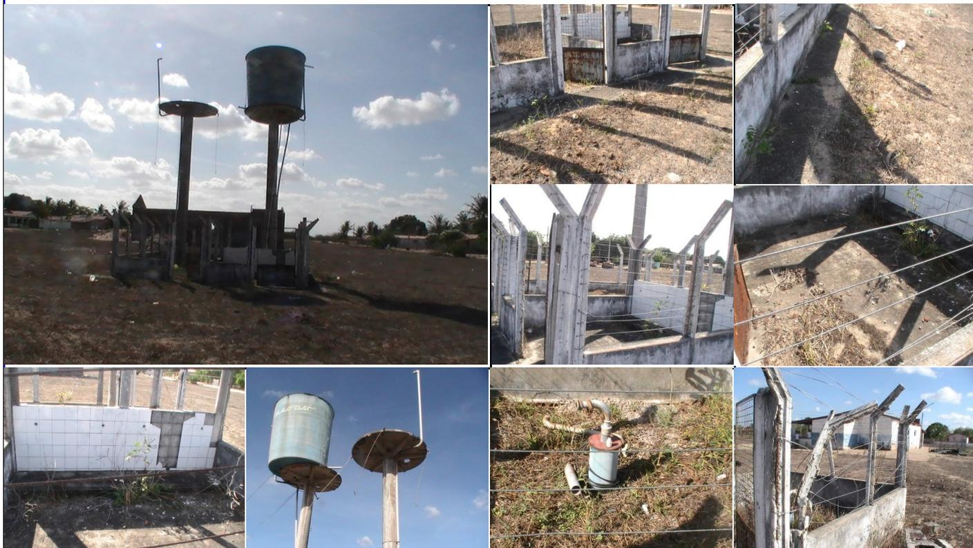
O sistema, composto por dois poços e um chafariz com duas caixas de vinte metros cúbicos, nunca funcionou por falta da instalação elétrica e por problemas interpessoais dos moradores do assentamento. Está abandonado.
