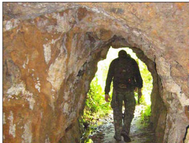
Figura 20 – Galeria abandonada na Mina Ribeirão da Prata (região de Nova Rússia, SC); veio mineralizado em diagonal no teto da galeria.
