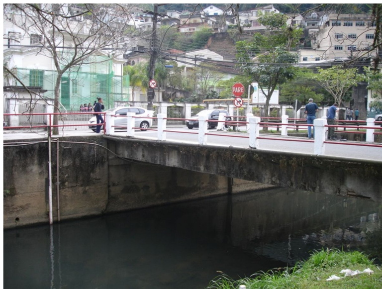
Figura 20 - Estação Liceu no Centro de Petrópolis, na bacia de uso Urbano.
