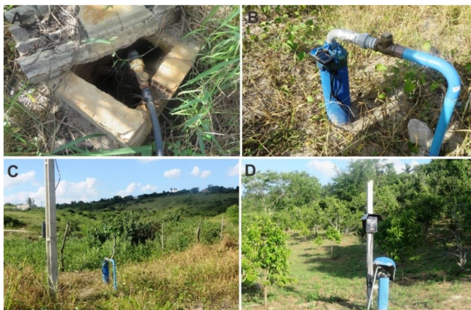
Figura 2.9 - Poços tubulares cadastrados na área do Sítio Gravatá. O poço (D) na granja Padre Cícero tem 94 m de profundidade e sua água possui condutividade elétrica que indica boa potabilidade.
