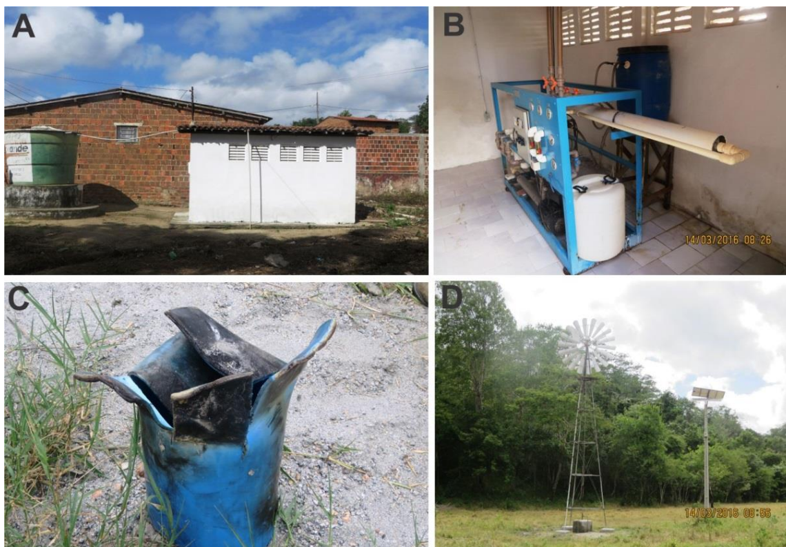
Figura 2.14 - Reservatório do poço (A) e dessalinizador (B) instalado na comunidade Chã do Marinheiro pelo Projeto Água Doce. C) Poço tubular abandonado com vazão informada de 5,0 \text{ m}^3/\text{h} e água com condutividade elétrica de 5.500 \mu\text{S}/\text{cm} . D) Poço tubular instalado com cata-vento. A condutividade elétrica da água é 4.700 \mu\text{S}/\text{cm} .
