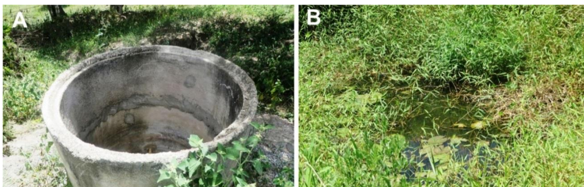
Figura 2.6 - A) Poço amazonas seco. B) Poço escavado no aluvião com água muito salinizada.
