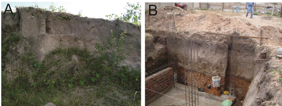
Figura 3.6 - A) Eluvião arenoso arcossiano capeando muscovita-biotita gnaiss da unidade Cariris Velhos (3,5 m de altura). Observe que há formação de um paleoterraço aluvial (presença de estruturas planares acanaladas) acima do eluvião; B) Cobertura coluvial? arenosa sobre saprólito do augengnaiss da Unidade Cariris Velhos.
