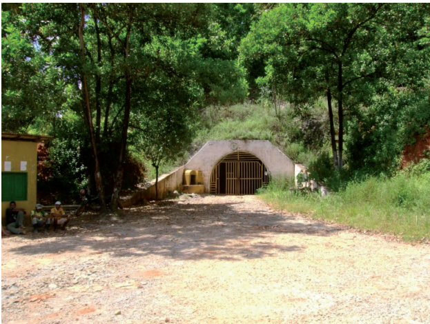
Figura 6.6 - Portão principal de entrada de acesso às galerias subterrâneas da antiga Mina Salamangone, hoje desativada.
