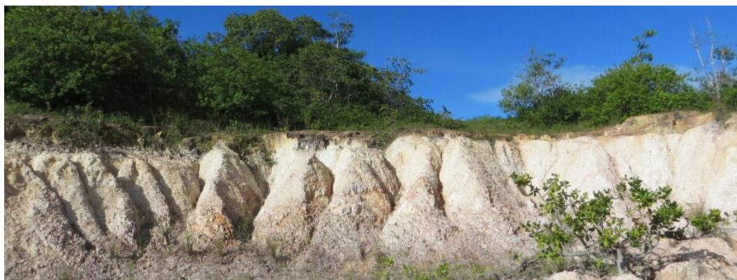
Figura 3.62: Colinas e talude - Corte de estrada fortemente erodido, município de Ipojuca. Foto: Arquivo do projeto Mapa Geodiversidade da Região Metropolitana do Recife-RMR, 2018.
