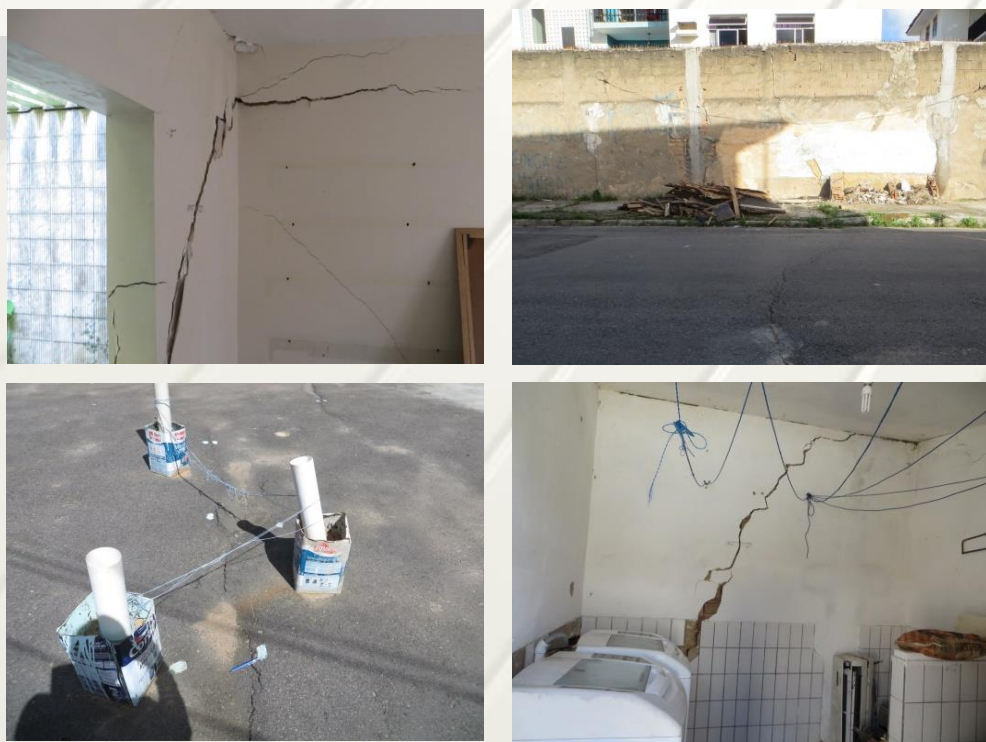
Figura 4: Características das trincas que retratam a área de alta instabilidade no terreno.
