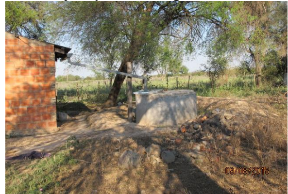
Aljibe que colecta agua de lluvia
