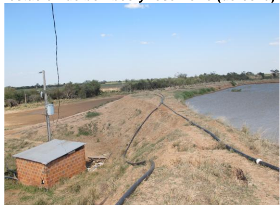
Tajamar pulmón (izquierda), estación de bombeo y reservorio (derecha)
