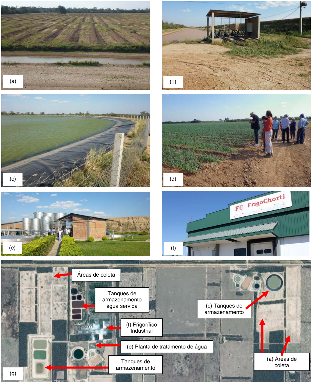
Figura 10 – Região de Loma Plata: utilização de água de chuva para irrigação e indústria. (a) área de captação mostrando o canal principal de coleta; (b) posto de bombeamento do canal de coleta para o reservatório principal de acumulação ( tajamar pulmão ); (c) reservatório de acumulação impermeabilizado com lona; (d) utilização da água para irrigação de cebola (gotejamento); (e) planta de tratamento da água de chuva para uso industrial; (f) frigorífico industrial (atualmente em expansão) abate hoje até 800 animais/dia; (g) vista aérea panorâmica da região, mostrando todos os pontos visitados.
