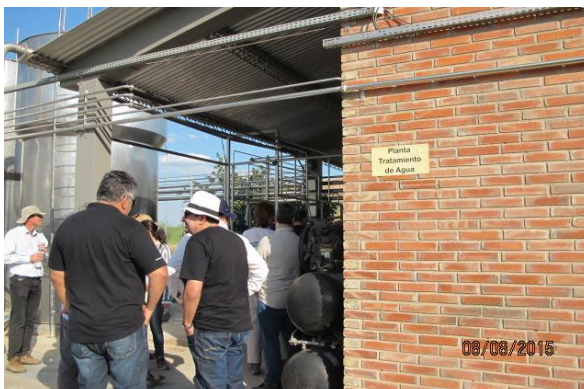
Planta de Tratamiento
