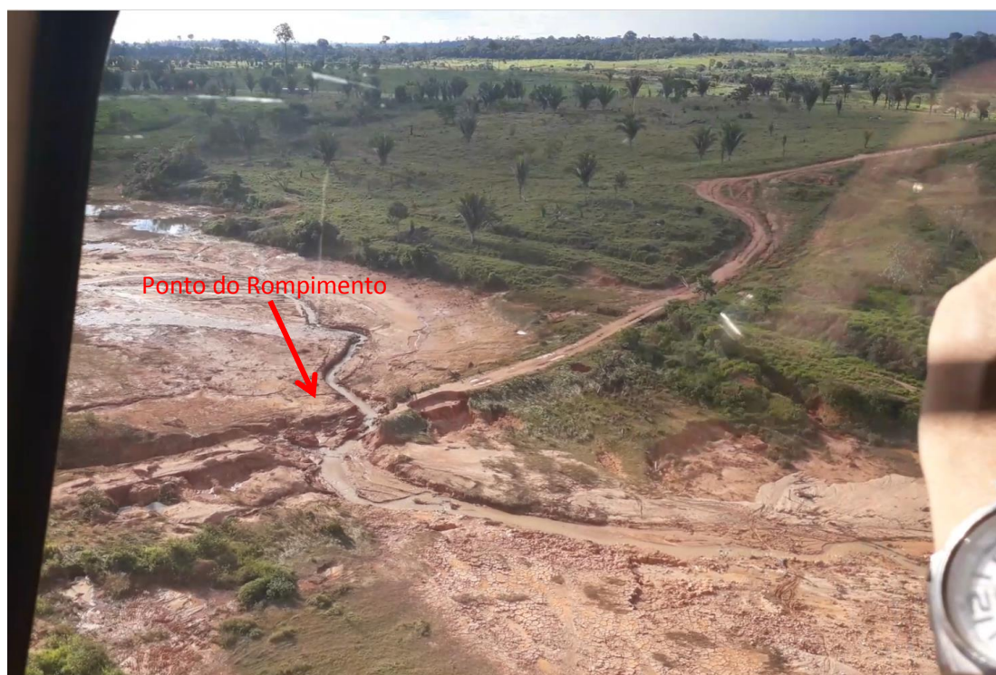
Figura 14 - Ponto 03 – Vista Aérea para Montante. Fonte: Vídeo obtido pela CPRM no dia 01/04/2019.
