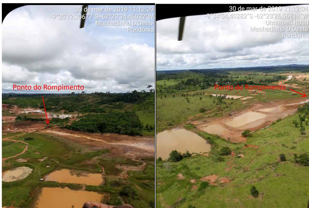
Figura 10. Visão da margem esquerda e direita da área de acúmulo de água do Ponto 01. Fonte: Fotos obtidas pela SEDAM no dia 30/03/2019.
