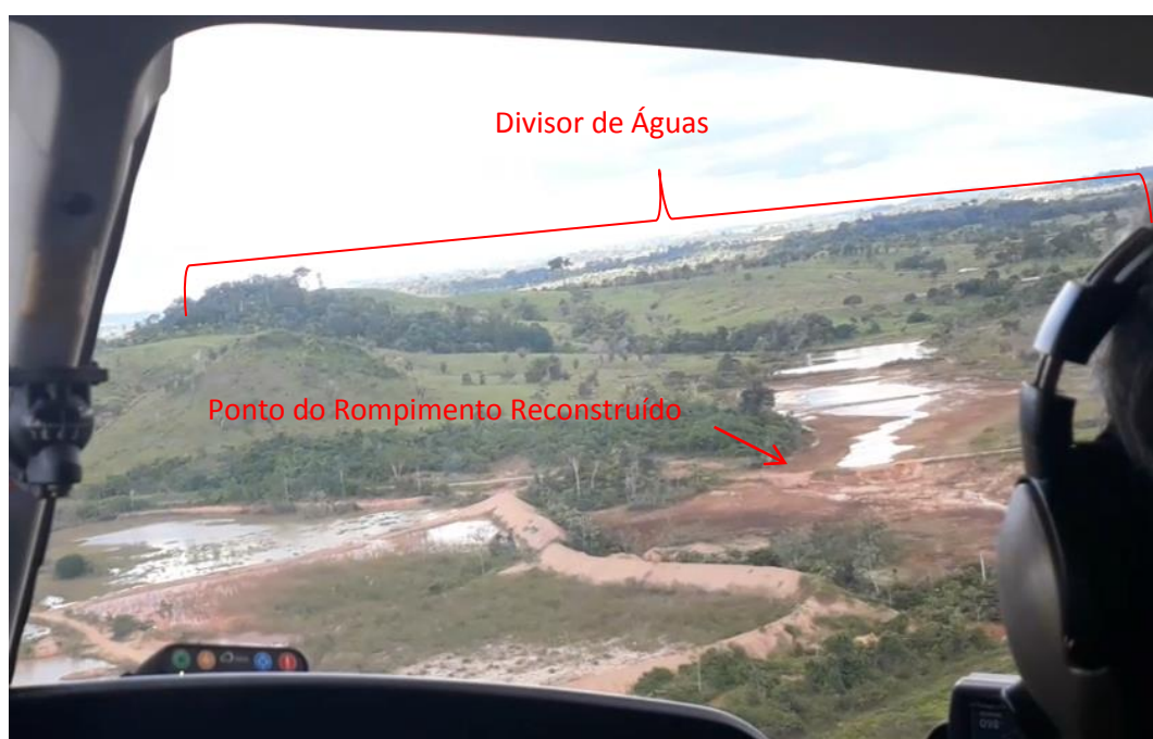
Figura 9. Visão para Montante do Ponto 01. Fonte: Vídeo obtido pela CPRM no dia 01/04/2019.
