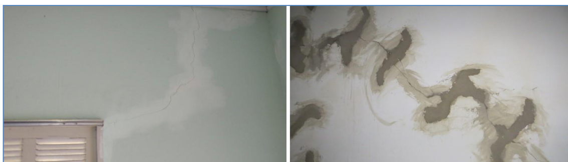
Figura 8. Feições indicativas que o processo de abertura continua ativo.
