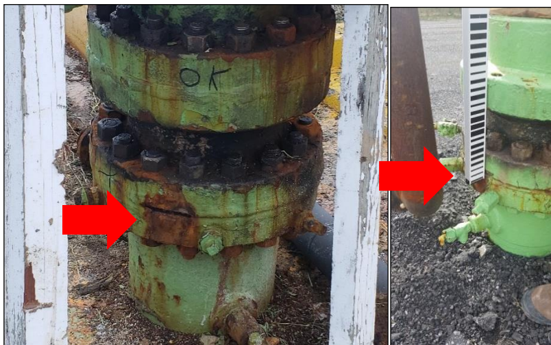
Figura 7. Ponto de referência para obtenção das coordenadas altimétricas
