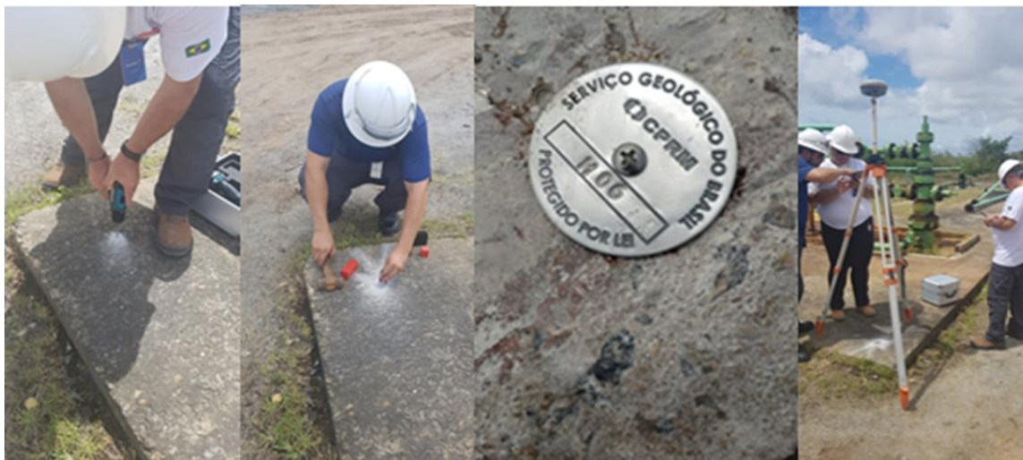
Figura 3. Instalação de chapas identificadoras e ocupação com GPS nas minas da Braskem
