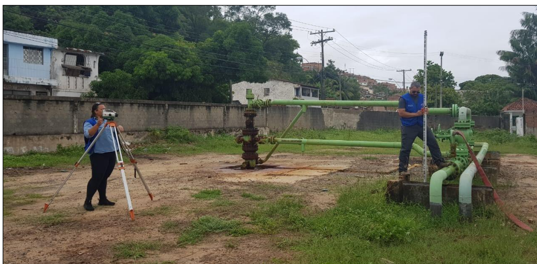
Figura 8. Nivelamento geométrico utilizando uma RN como leitura de Ré
