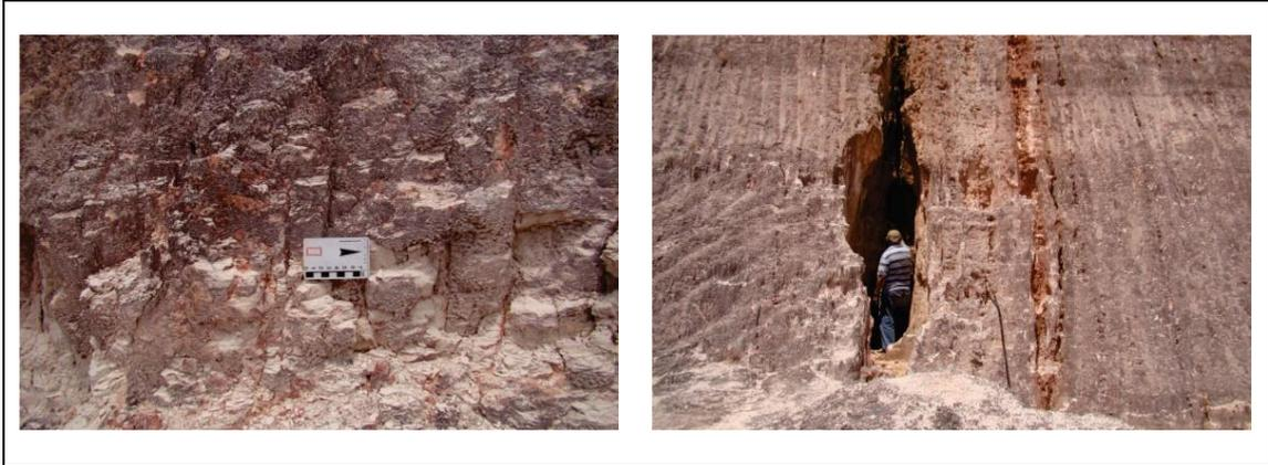
**Figuras 9 e 10.** Esquerda: exemplo do fraturamento intenso em camadas mais argilosas. Direita: grandes ravinamentos devido à infiltração de água superficial.
