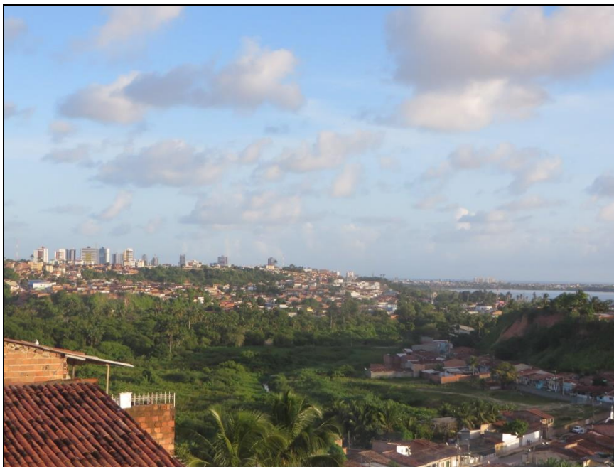
Figura 07. Ampla planície fluviomarinha embutida em vale encaixado do riacho do Silva, delimitado por encostas declivosas sustentadas por sedimentos do Grupo Barreiras. O fundo de vale encontra-se parcialmente ocupado por casario humilde que avança sobre manguezais e áreas embrejadas. Ao fundo, observa-se um ângulo lateral da comunidade do Mutange ocupando a encosta da borda do tabuleiro. No topo do tabuleiro, salientam-se os edifícios do bairro Pinheiro.
