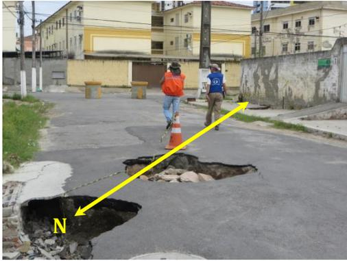
**Figura 12.** Grande desenvolvimento erosivo de trinca N-S no entorno do condomínio Divaldo Suruagy.
