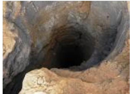
**Figura 8.** Sumidouro colapsado ao lado do Condomínio Jardim das Acácias, Pinheiro, mostrando solo cinza a cinza escuro (Fonte: Alagoas 24 horas).
