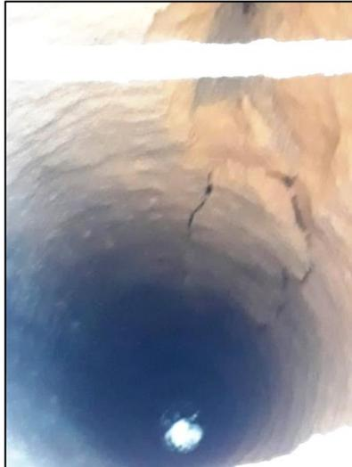
**Figura 15.** Trinca conectada a sumidouro (Fonte: Defesa Civil de Maceió)
