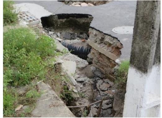
**Figura 13.** Detalhe das feições erosivas da imagem anterior.
