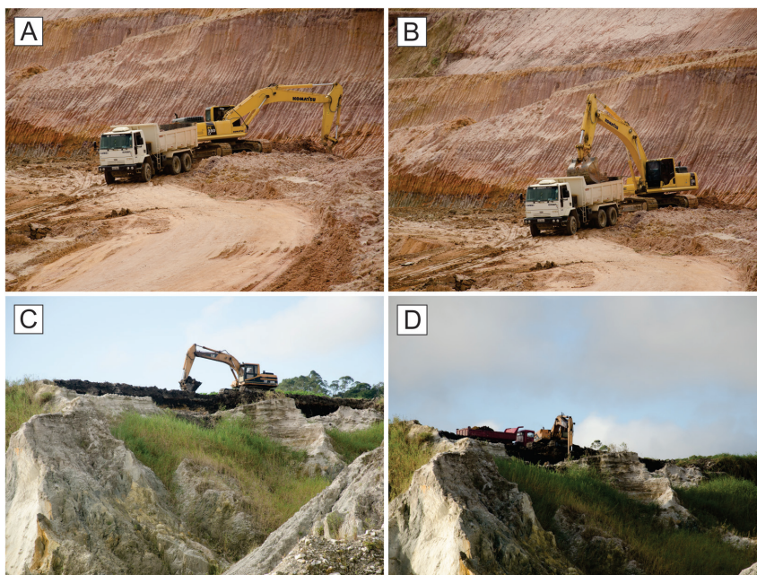
Figura 6.1 - (A) Escavação de areia utilizando retroescavadeira; (B) Carregamento de material escavado em caminhão para transporte; (C) Decapeamento de material estéril superficial (turfa) que recobre área de mineração de areia; (D) Carregamento de material escavado para transporte e recomposição de áreas já lavradas anteriormente.
