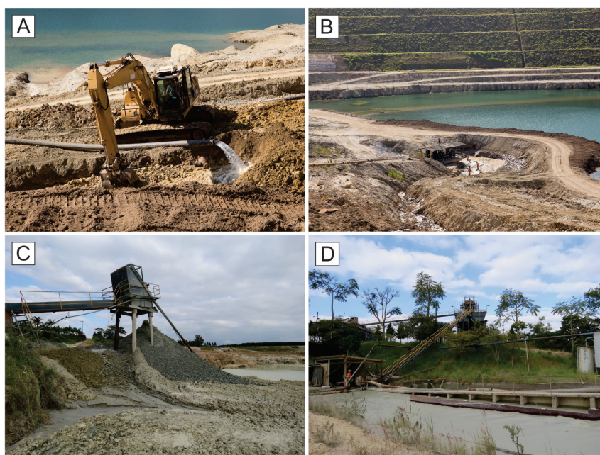
Figura 6.3 - (A) Transformação de material a ser lavrado em polpa, com auxílio de retroescavadeira; (B) Bombeamento da polpa para beneficiamento; (C) Separador de cascalho da polpa por meio de grade; o cascalho forma uma pilha abaixo do equipamento; (D) Separação de materiais finos em tanque de recuperação. A polpa com areia é bombeada para silos, onde é armazenada e perde água.
