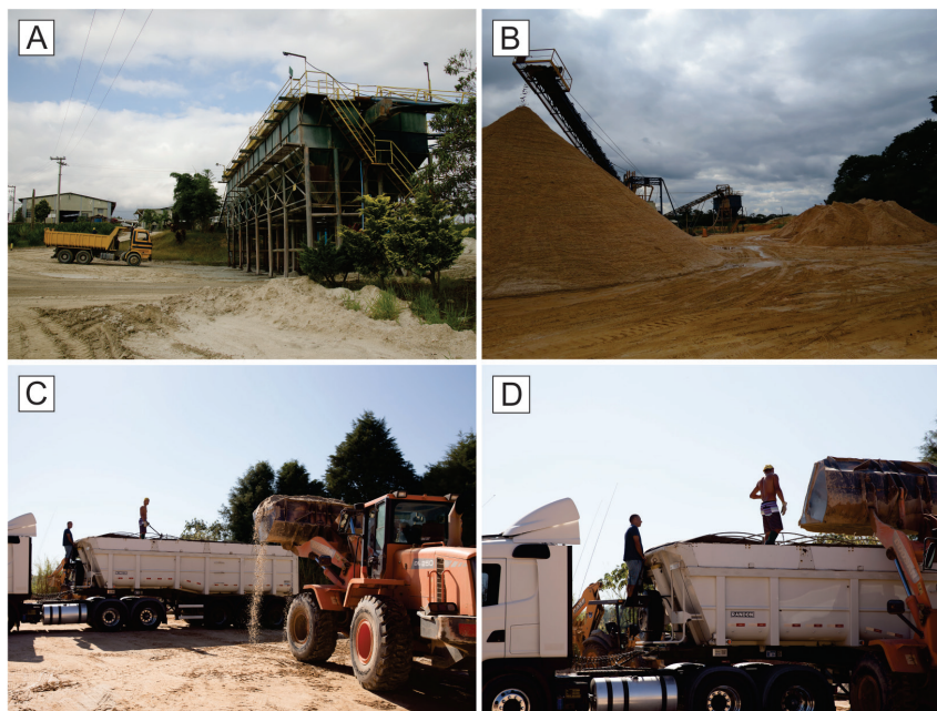
Figura 6.4 - (A) Transformação de material a ser lavrado em polpa, com auxílio de retroescavadeira; (B) Bombeamento da polpa para beneficiamento; (C) Separador de cascalho da polpa por meio de grade; o cascalho forma uma pilha abaixo do equipamento; (D) Separação de materiais finos em tanque de recuperação. A polpa com areia é bombeada para silos, onde é armazenada e perde água.
