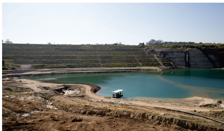
Figura 8.4 - Revegetação de taludes em lavra de areia já nas fases finais de operação no município de Itaquaquetuba
