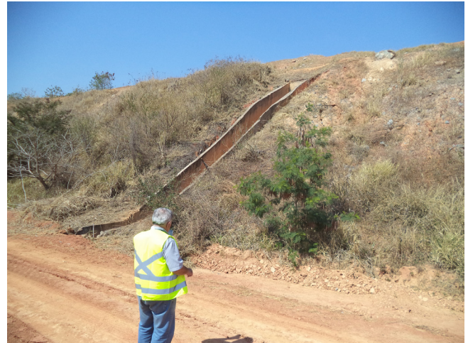
Figura 8.2 - Pilha de rejeito reambientada em mina de calcário (Matozinhos).
