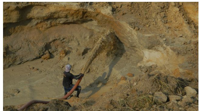
Figura 6.2 - Desmonte hidráulico por jateamento d'água em manto de alteração (ponto 159 – região de Esmeraldas).
