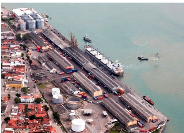
Figura 2.2 - Vista aérea do porto de Cabedelo (PB). Fonte: Companhia Docas da Paraíba/Porto de Cabedelo.
