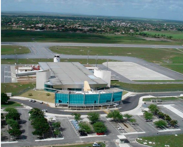
Figura 2.5 - Vista aérea do Aeroporto Internacional Presidente Castro Pinto (Bayeux, PB). Fonte: Infraero.
