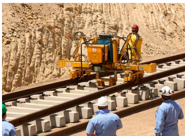
Figura 2.4 - Trecho em construção da ferrovia Transnordestina, entre Trindade (PE) e Eliseu Martins (PI). Fotografia: Thiago Amaral /Cidade Verde, 2016.
