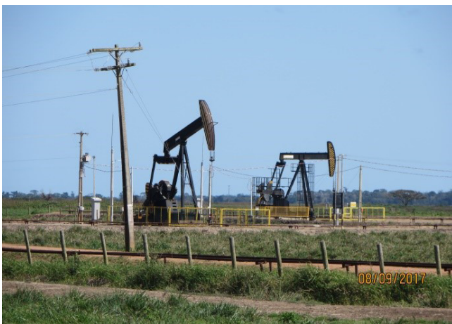
Figura 14.5 - Unidades de bombeamento em campo de produção da Petrobras (UTM: 417560m E; 7860711m N) (Foto: Fábio Lima Noronha).
