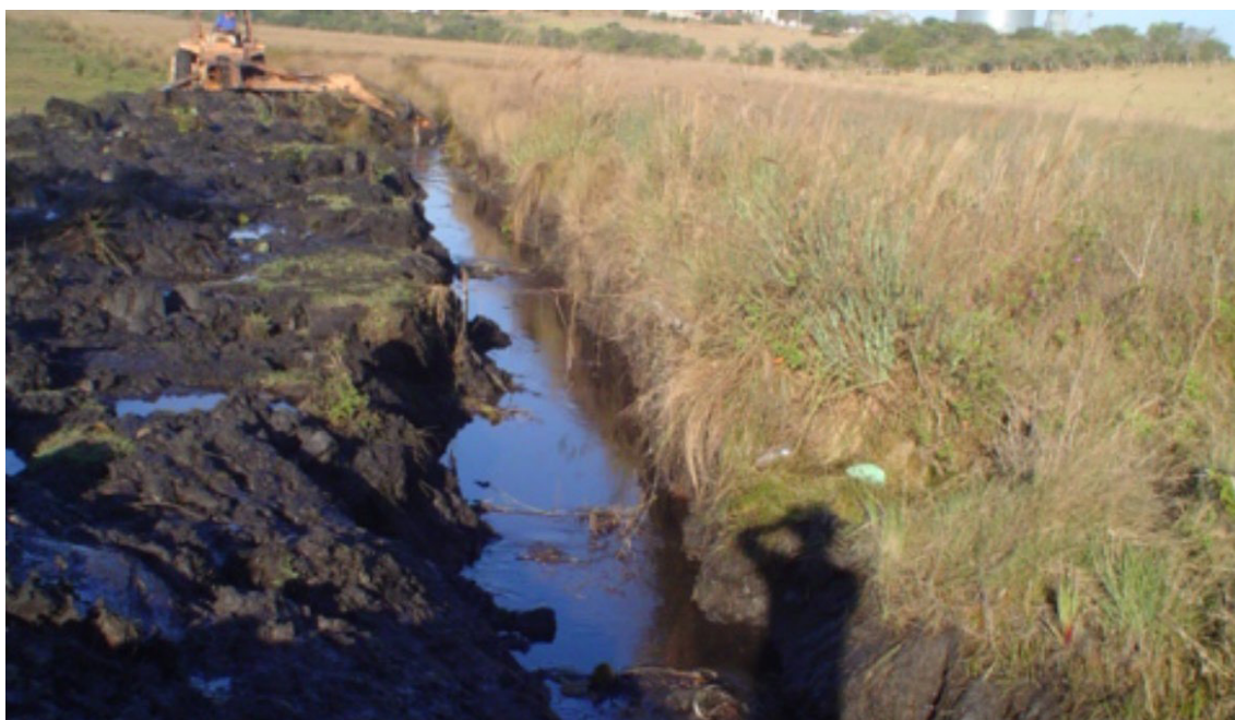
Figura 12.1 - Abertura de um canal de drenagem em meio a uma região pantanosa com depósitos de turfa (MINERAÇÃO VARGINHA, 2017).
