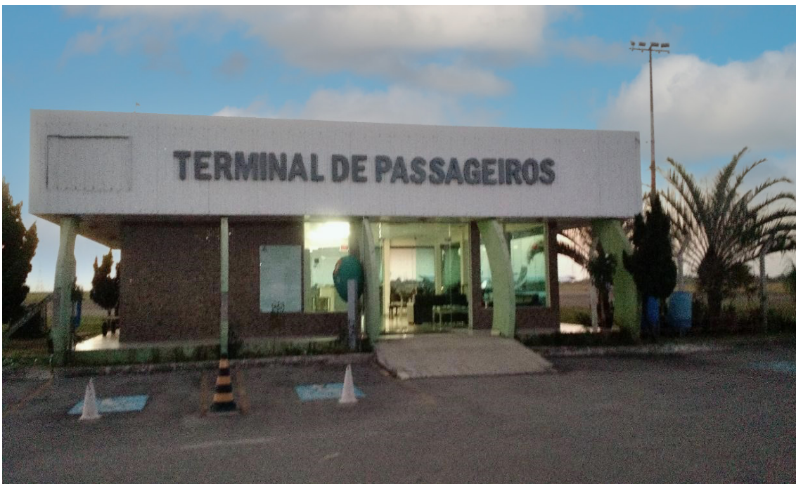
Figura 2.3 - Aspecto da fachada do acesso ao Aeroporto de Linhares (Foto: Hamilcar Tavares Vieira Júnior).
