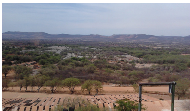
Figura 4 - A bacia de rejeito e a proximidade de bairro residencial e da sede municipal.
