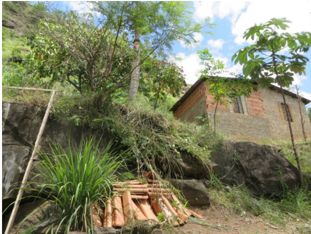
Figura 4. Moradia de baixo padrão construtivo na base da encosta em risco a queda de blocos.
