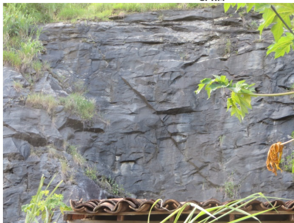
Figura 8. Descontinuidade persistente na face do paredão da pedreira abandonada.
