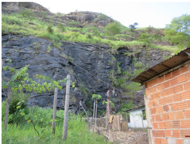
Figura 21: Ponto 11 – Moradias construídas em área de pedreira desativada.
