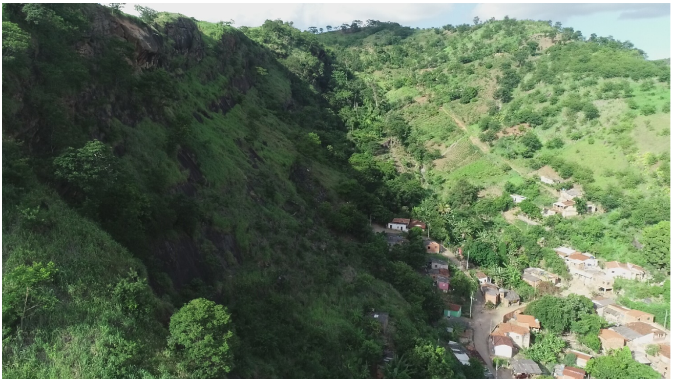
Figura 6. Visão geral da morfologia da encosta e das residências em risco.
