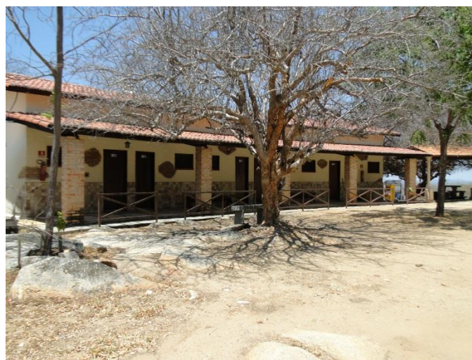
Figura 29 – E) Instalações do Hotel Pedra dos Ventos, localizado na Serra dos Ventos. Município de Quixadá. (Foto: Rogério Valença, 2019).
