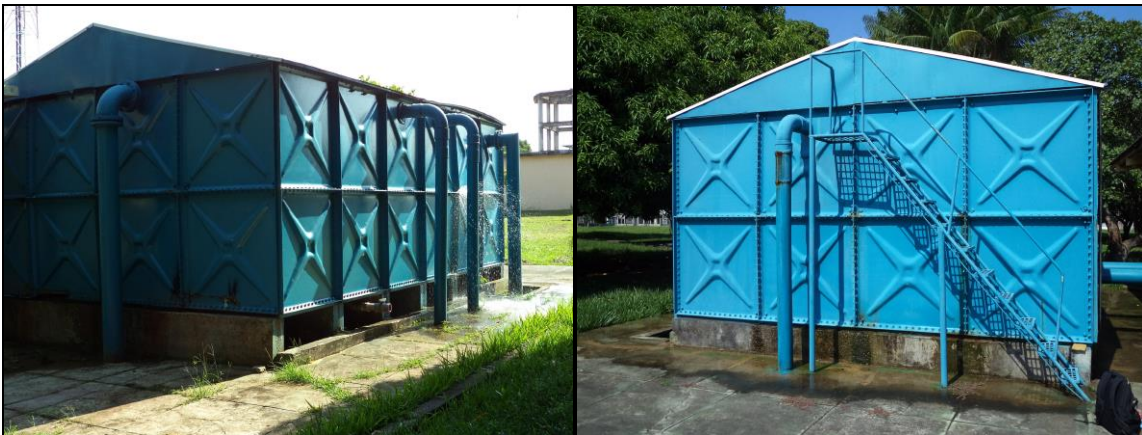
Figura 8: Reservatório de ferro da Estação de Bombeamento II, com corrosão que provoca rachaduras e vazamentos da água aí armazenada.
