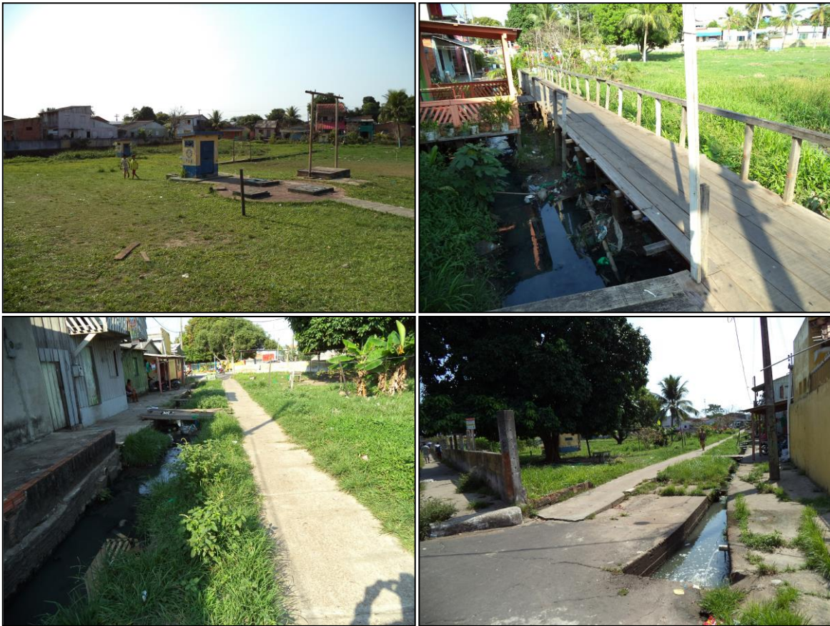
Figura 3: Aspectos do terreno da Estação de Bombeamento I, a leste da rua Rio Branco, sem muro de proteção e ladeado por um canal de esgoto a céu-aberto que acompanha o Beco Submarino
