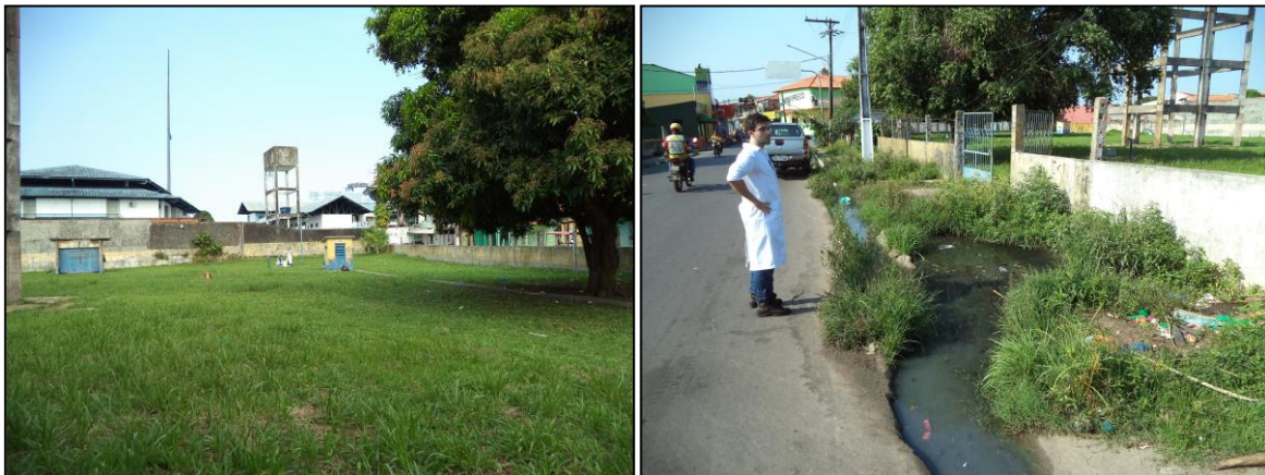
Figura 4: Terreno da Estação de Bombeamento I, a oeste da rua Rio Branco, com esgotos domésticos escorrendo no meio-fio em frente ao portão de acesso ao terreno.
