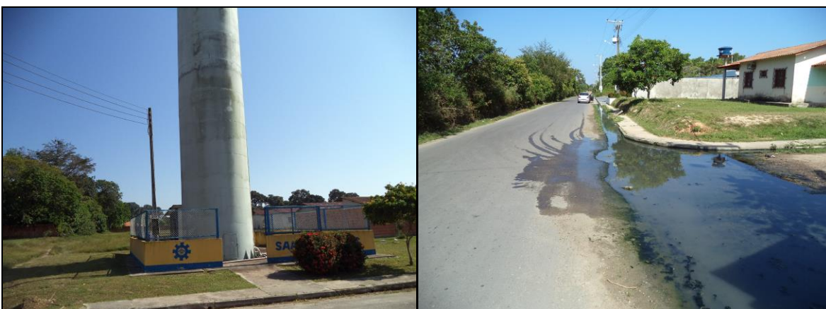
Figura 18: À esquerda, local do poço do Condomínio Vila Cristina, que alimenta caixa de água de aço com 20m 3 ; à direita, acúmulo de esgotos domésticos a céu-aberto, na entrada do condomínio, a cerca de 200m do poço.
