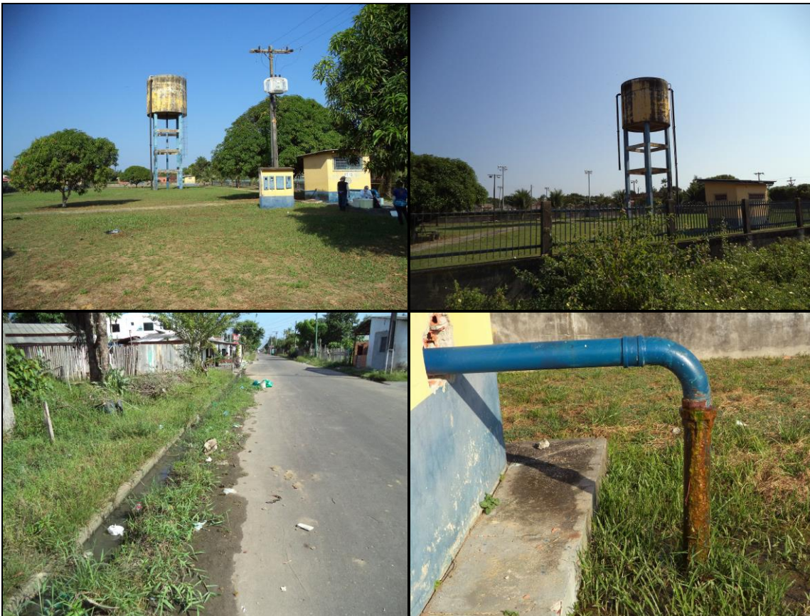
Figura 11: Acima, vistas do terreno da Estação de Bombeamento III; abaixo, acúmulo de esgoto doméstico no meio-fio da rua Guajarina Prestes e vazamento na tubulação do poço PT-14.
