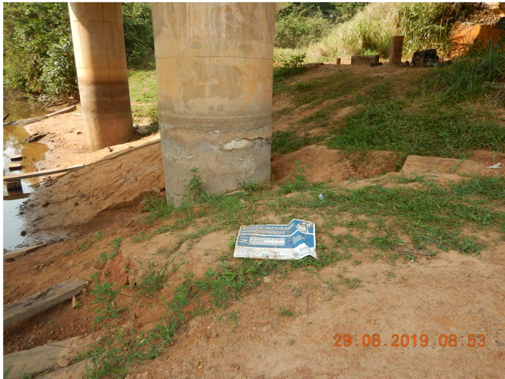
Figura 10 – Estação fluviométrica de São Francisco do Guaporé/RO.
