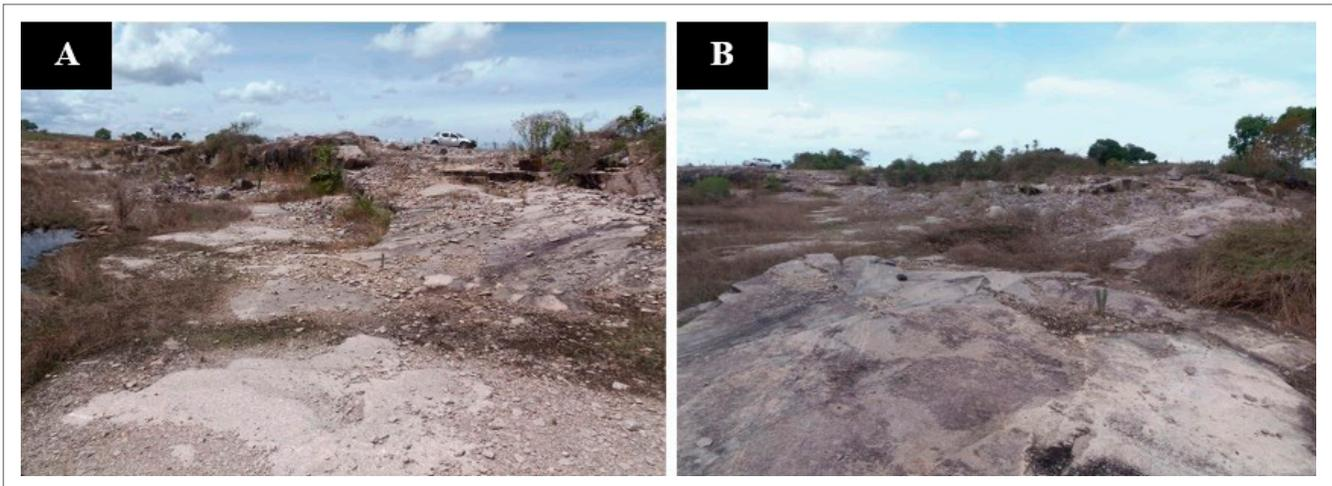
**Figura 6.4** - Lavra garimpeira de insumos para construção paralisada em virtude da utilização indevida de explosivos. (A) Desmonte sem planejamento; (B) Outro trecho da mesma lavra onde se observa a exposição da área, sem nenhuma proteção ou sinalização. Pedras de Fogo (HM-245).
