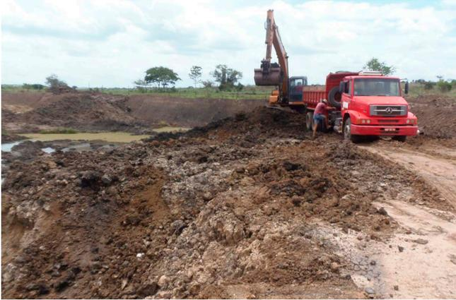
**Figura 5.8** - Extracção de argila por desmonte mecânico e posterior carregamento em caminhão basculante, para transporte da Fazenda Santo Antônio (coordenadas: 7°8'44,5"S/35°07'19,9"W) em Santa Rita-PB.
