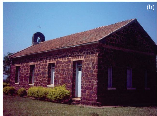
Figura 7.2 – (a) Aspecto macroscópico de afloramento de laterita (localizado no sudoeste da área); (b) Igreja construída com blocos de laterita (Bela Vista, MS). Fotografia: Marcio José Remédio, 2009.
