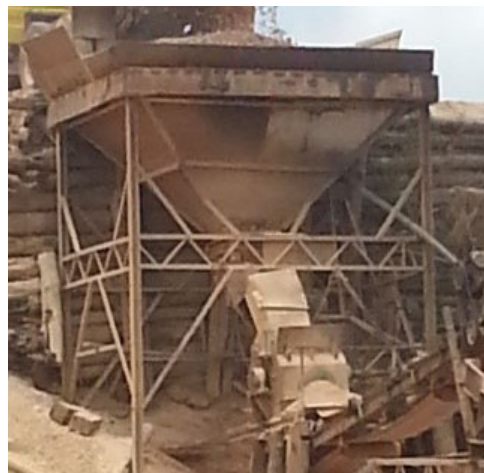
Figura 5.21 - Silo ou “moega”, usado para alimentar os equipamentos de beneficiamento.
