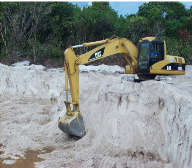
Figura 5.13 - Operação de decapeamento (retirada de areia branca, associada ao Pós-Barreiras, altamente lixiviado), realizada com carregadeira hidráulica (PC), no município de Ourém. Fonte: Fotografia do Arquivo da SEDEME.
