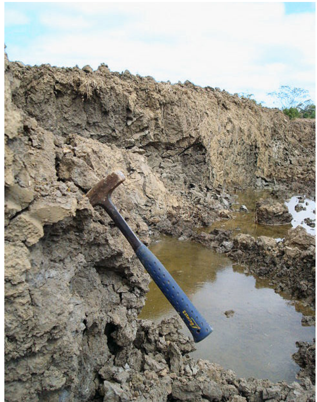
Figura 5.4 - Aspecto da escavação realizada em lagoa para retirada da argila (Pedra Branca II - 161ag).
