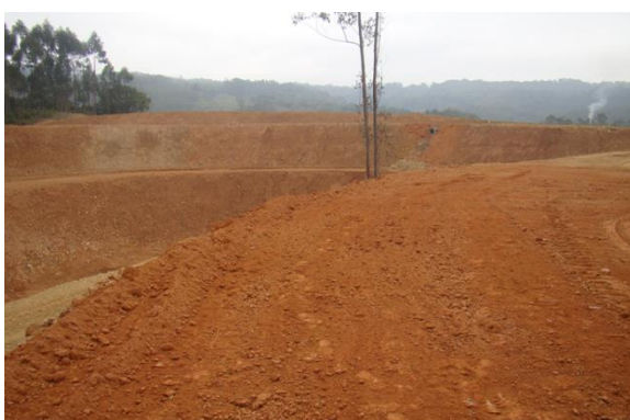
Fig 8. Cobertura de argila sobre os rejeitos sulfetados.
