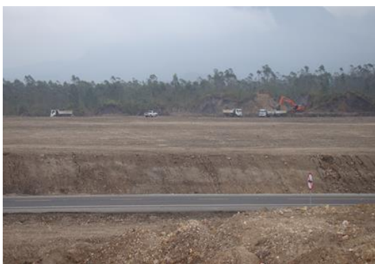
Fig 6. Conformação das pilhas de rejeito e reconstrução topográfica.
