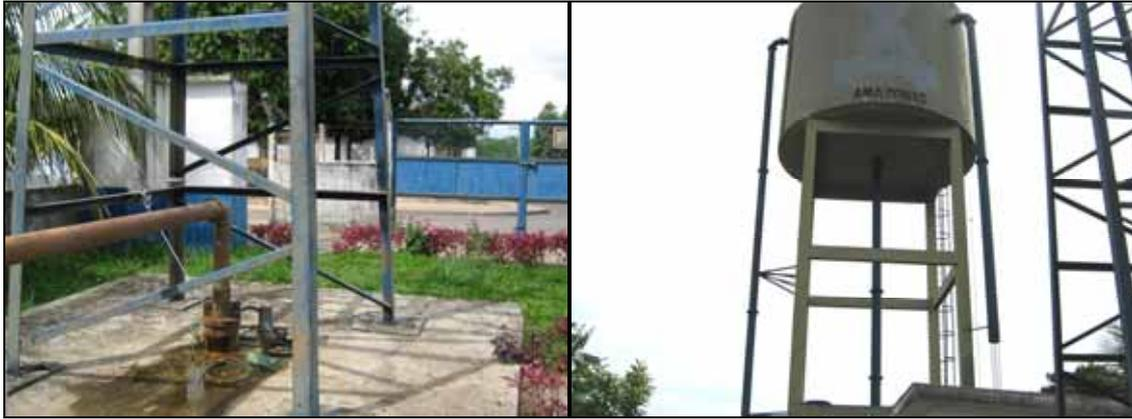
**Figura 7.12.2.3** – À esquerda, poço do SAAE PT-08 no Bairro São João; à direita, caixa d'água elevada, de 80 m<sup>3</sup>, parcialmente alimentada pelo poço PT-08.
