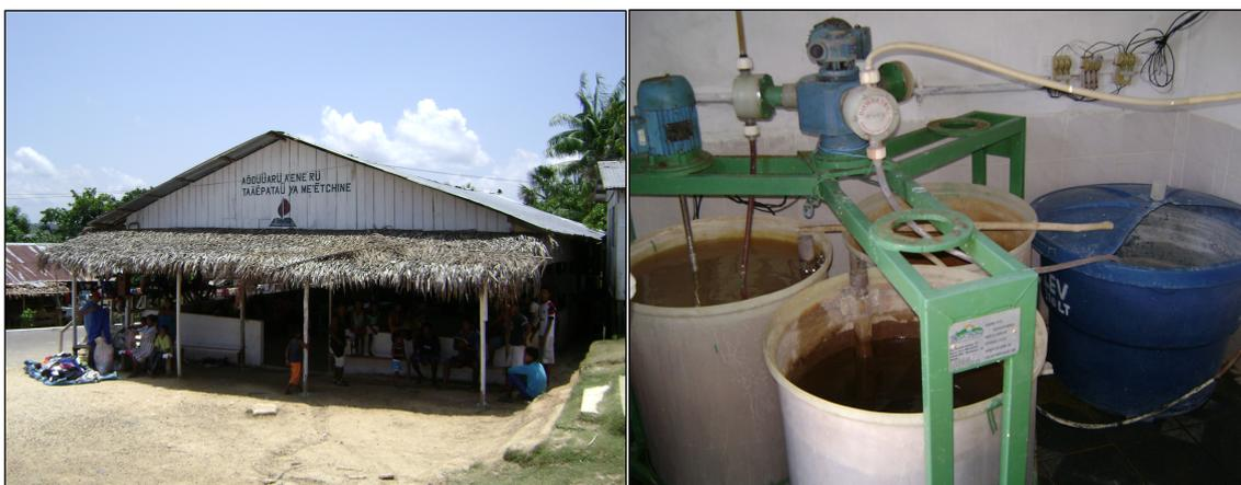
**Figura 7.2.2.5** – Comunidade Indígena Feijoal: à esquerda, centro de convivência; à direita, vista das bombas dosadoras de sulfato de alumínio da ETA existente na comunidade.
