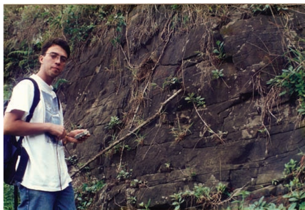
Figura 3.44 – Fraturamento subhorizontal em diabásio de dique no alto de divisor de águas entre os córregos do Sertão e Conceição, 12 km a sudeste de Sumidouro
