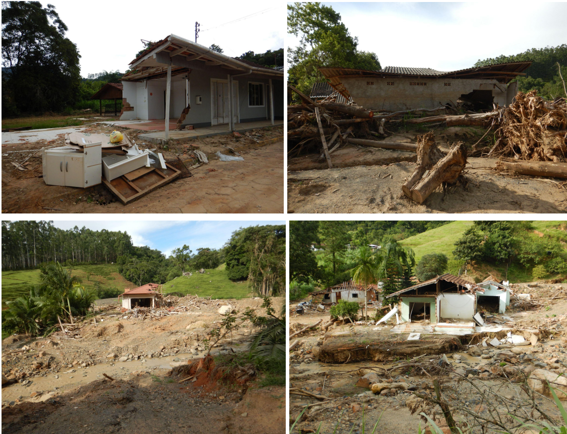
Figura 26: Exemplos de construções destruídas ou danificadas pelo fluxo de detritos em Presidente Getúlio - SC.
