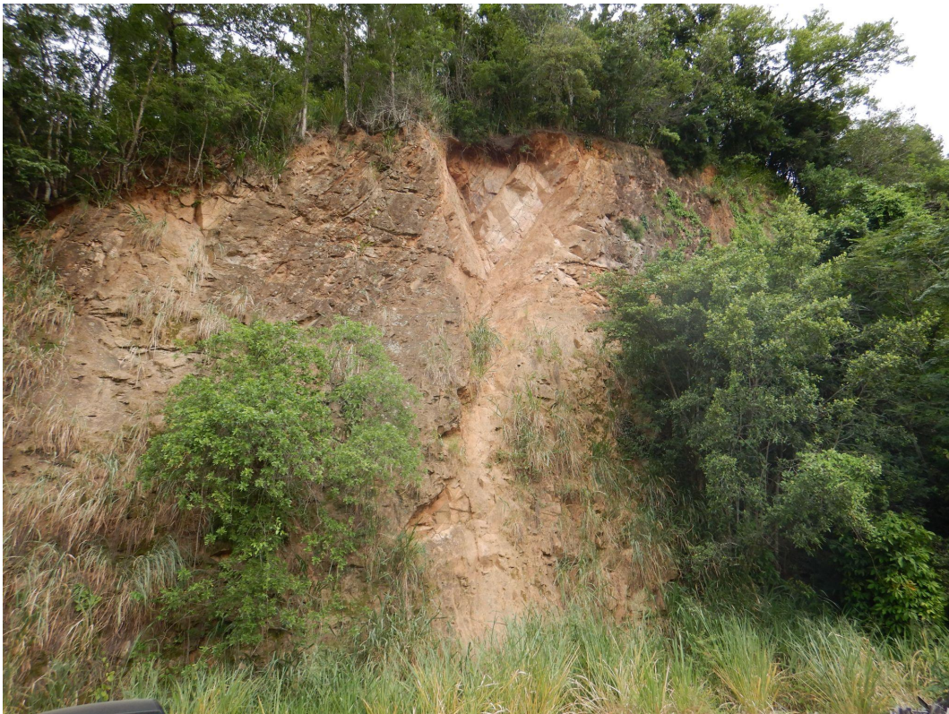
Figura 20: Controle estrutural com alta potencialidade a indução de MGMs; Ex: Deslizamento do tipo Cunha, Presidente Getúlio - SC.
