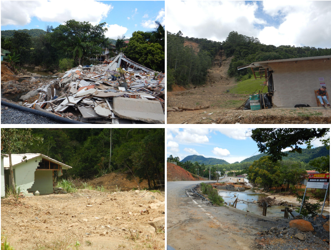
Figura 25: Exemplos de construções destruídas ou danificadas pelo fluxo de detritos em Rio do Sul - SC.
