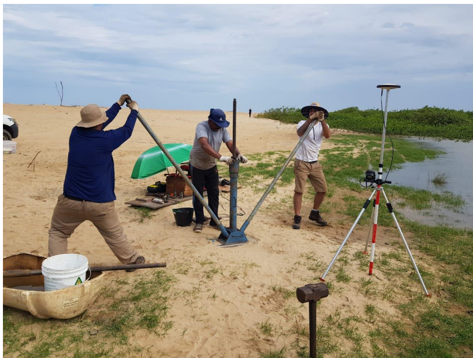
Figura 36: Saque das hastes com uso de um macaco mecânico.
