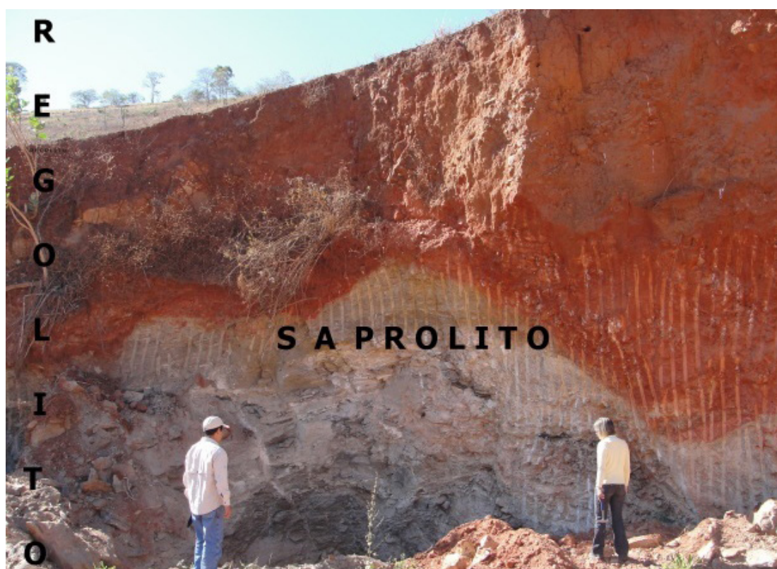
Figura 01 - Denominação dos materiais resultantes do intemperismo das rochas. Perfil de alteração em corte de estrada em domínio de morros altos, situado nas cercanias da localidade de Vila Nova do Bananal, município de Baixo Guandu, ES. Foto: Marceley Ferreira Machado.
